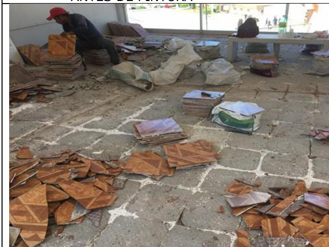
ANTES DE PINTURA Y LOSETA EN CASINO
