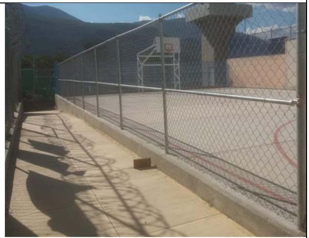
Cancha terminada con andadores
