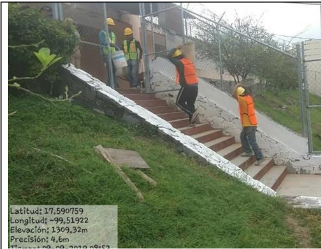
Lugar donde se construira andador de acceso
