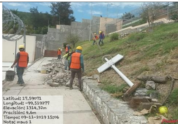
Corte de talud para edificio de pedagogía
