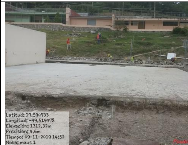
Excavaciones para cancha
