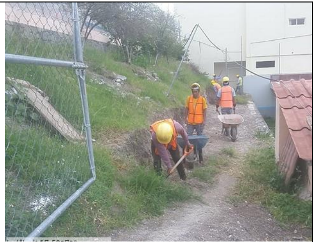
Excavaciones para andadores de acceso
