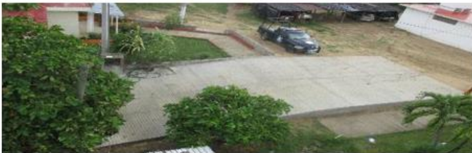
ELABORACION DE RAMPA Y MURO DE CONTENCIÓN
