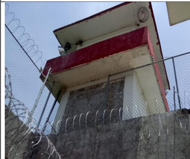
Torre antes de remodelación
