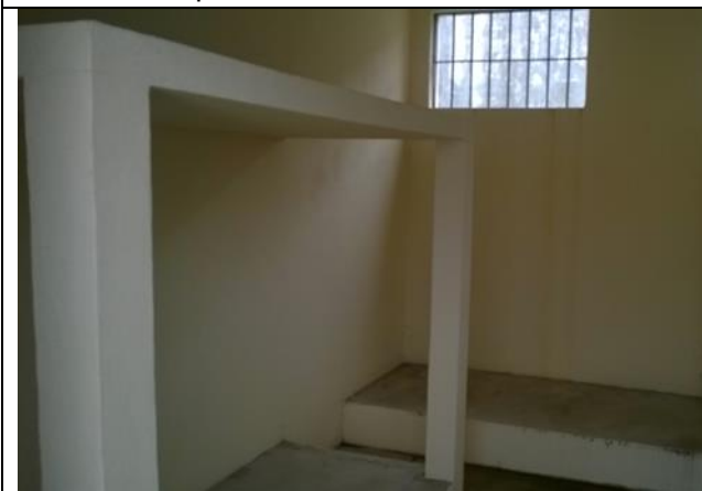
Dormitorios sin escalera
