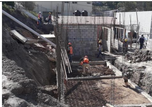
Proceso de construcción de edificio de pedagogía
