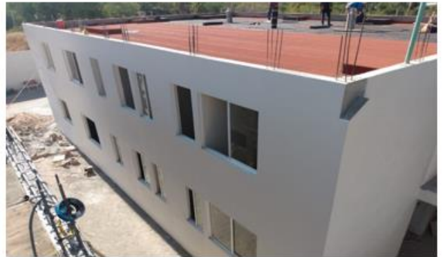
PROCESO DE LOS TRABAJOS
