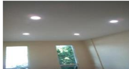
CAMBIO DE LUMINARIAS Y ARREGLO DE PLAFONES
