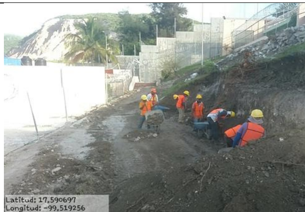
Excavaciones para edificio de pedagogía
