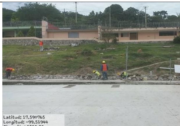
Corte de talud para edificio de pedagogía
