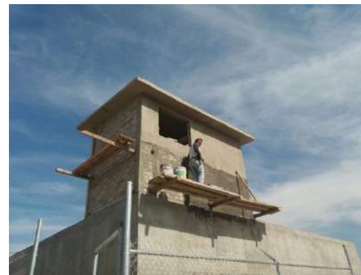
Caseta de control cárcamo de bombeo tanque Acatempa.
