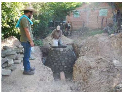
Pozo de visita en proceso.
