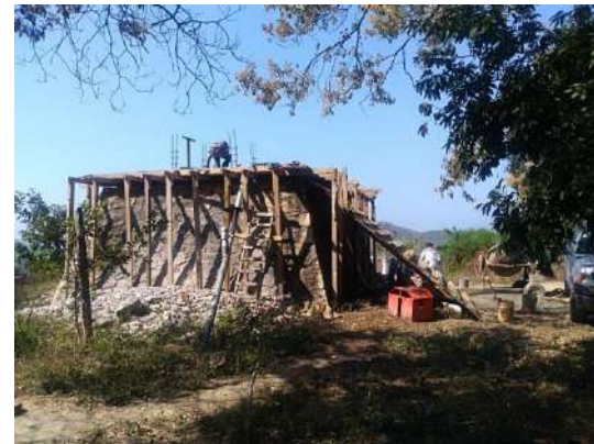
Rehabilitación de tanque de regularización de 100 m3.
