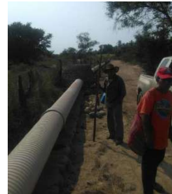
Colector instalación de tubería PVC y pozos de visita.
