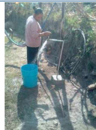
Prueba de tomas domiciliarias.
