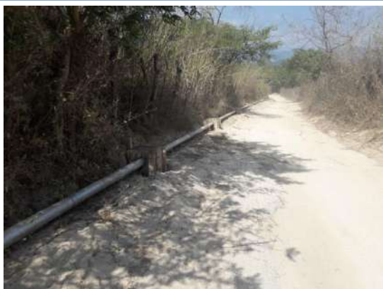
Línea de conducción de tubería Fo.Go.
