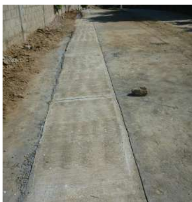
Red de distribución instalación de tubería PVC, reposición de concreto.
