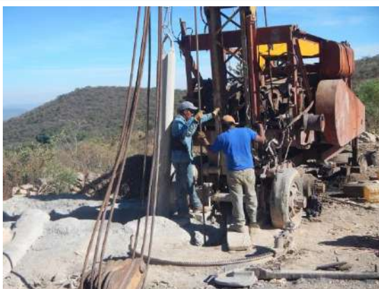
Perforación de pozo.
