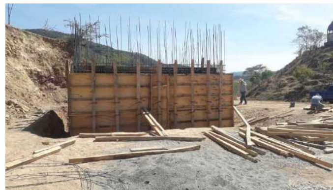
Construcción del tanque de 50 m3.
