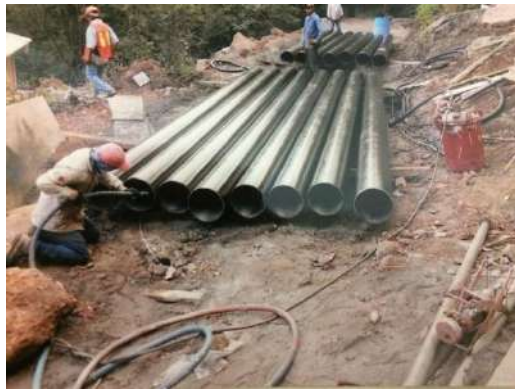
Samblasteo de tubería de acero.
