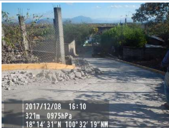
Ruptura de pavimento hidráulico para instalación de tubería PVC en la red de distribución.
