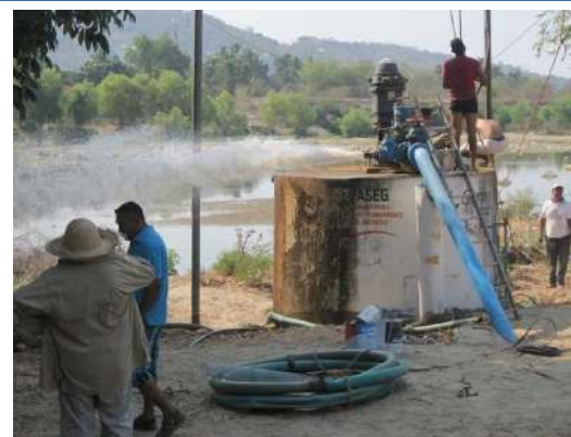
Rehabilitación de equipamiento.
