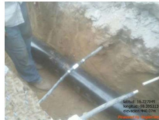
Línea de conducción instalación de tubería de acero.
