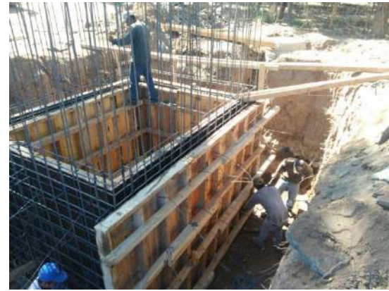
Cimbrado del cárcamo de bombeo en red de atarjeas.
