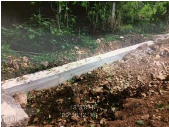
Encofrado de tubería en colector.
