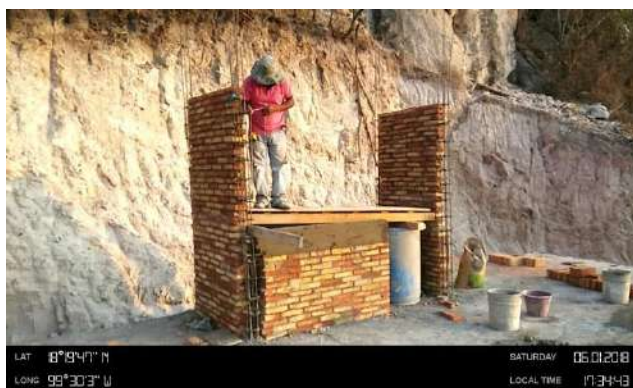
Construcción de caseta en el tanque.
