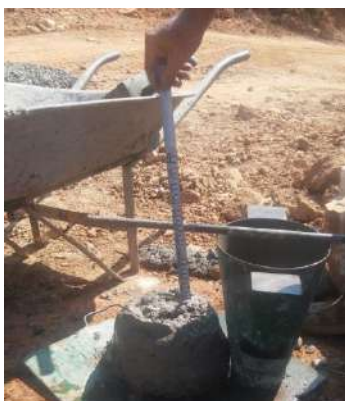
Prueba del concreto para colado del tanque.
