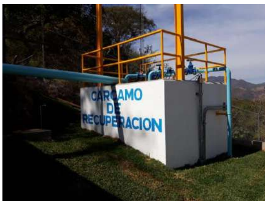
Estructura de PTAR.
