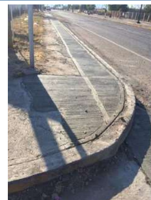
Reposición de pavimento hidráulico en la red de distribución.
