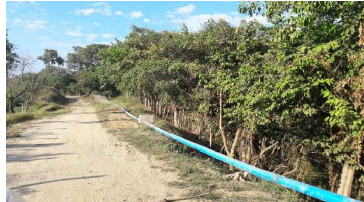
Línea de conducción de tubería de acero de 6" y atraques.
