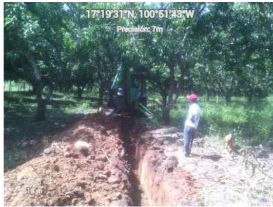
Excavación para instalación de tubería.
