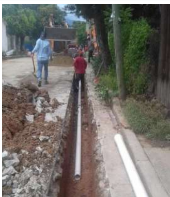
Red de distribución instalación de tubería PVC.
