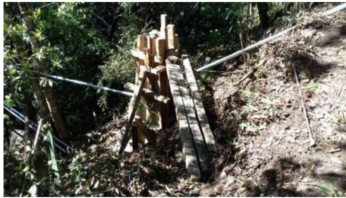
Línea de conducción instalación de tubería Fo.Go. de 1 ½".
