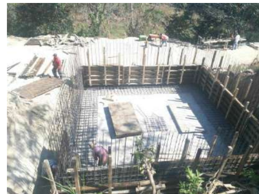
Tanque de regularización.
