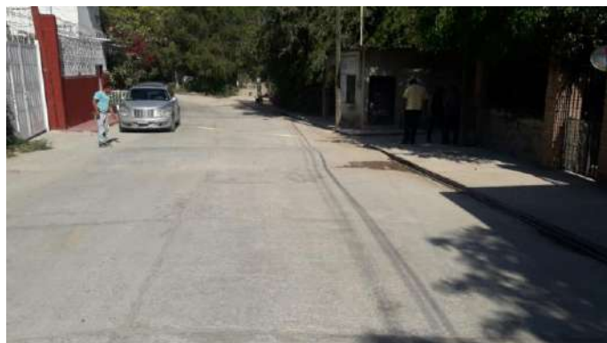
Reposición de concreto en la red de distribución.
