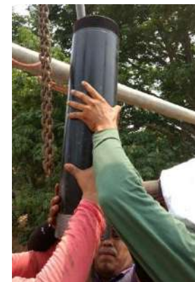
Rehabilitación de equipamiento.
