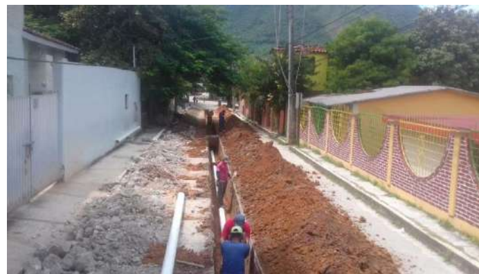
Red de distribución instalación de tubería PVC.
