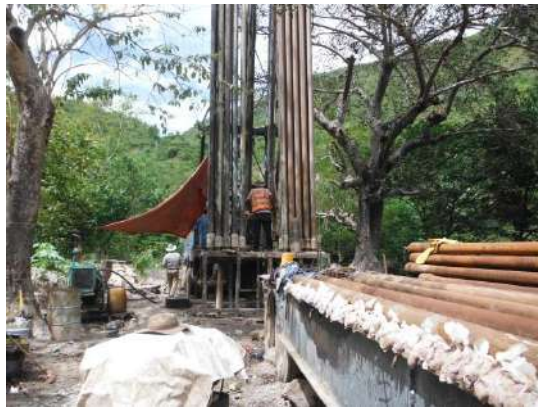
Perforación de pozo.
