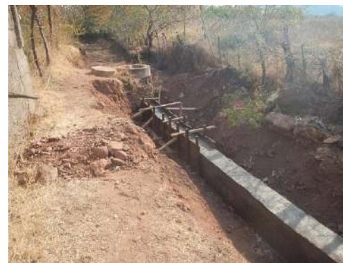
Encofrado de tubería PVC.
