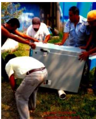
Rehabilitación del equipo de bombeo.
