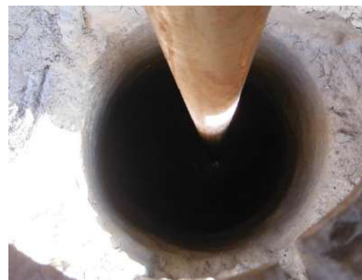
Perforación de pozo.
