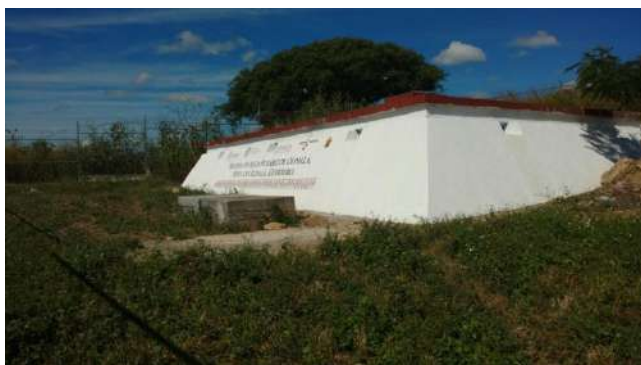
Tanque de almacenamiento.
