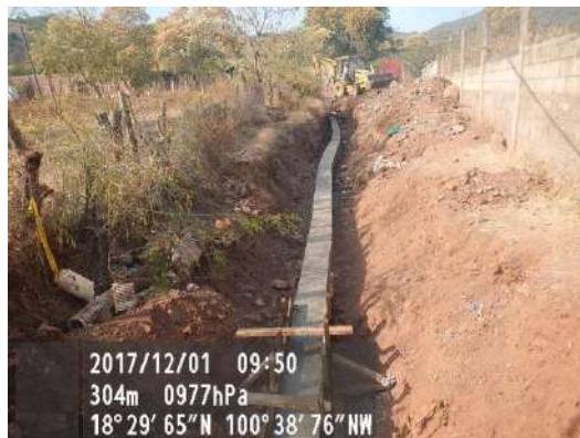
Encofrado de tubería PVC.
