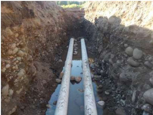
Galería filtrante horizontal.
