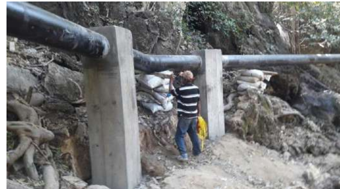
Colocación de tubería de acero y atraques.
