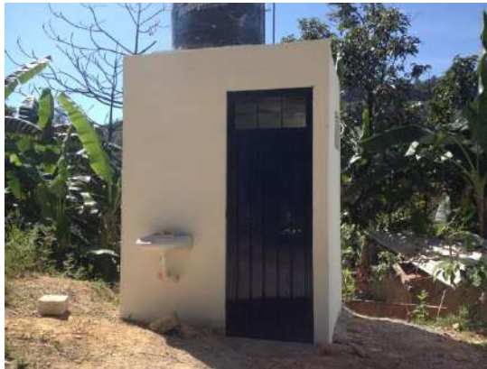
Sanitario digno con biodigestor.
