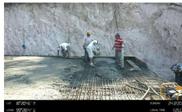
Colado de la losa del tanque.
