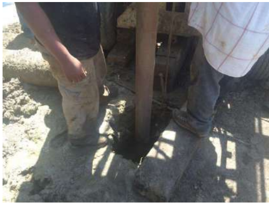
Perforación de pozo.
