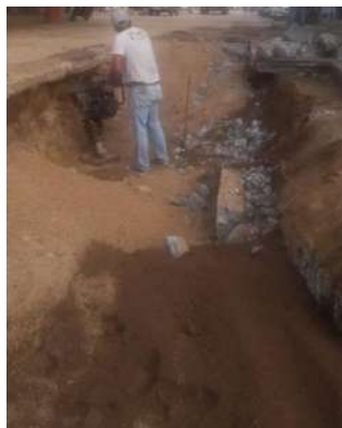
Relleno y compactación en el colector.
