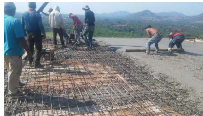
Colado del tanque.
