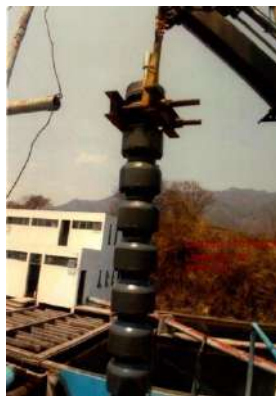
Rehabilitación del equipo de bombeo.
