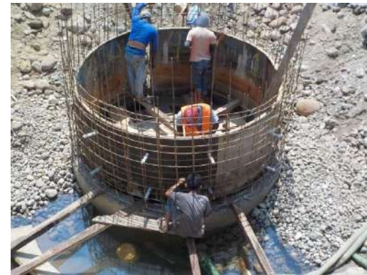
Galería filtrante horizontal.
