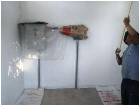
Colocación de pintura en el interior del tanque.
