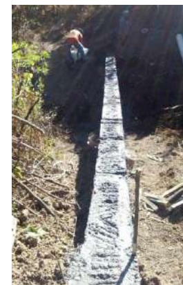
Encofrado de tubería PVC en la red de atarjeas.
