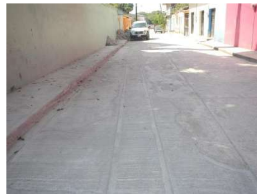
Reposición de concreto en red distribución e Instalación de tubería PVC.
