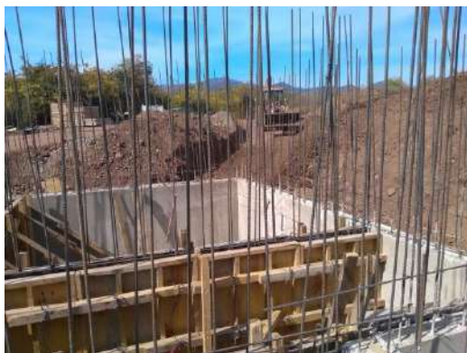
Colado en las estructuras de la PTAR.
