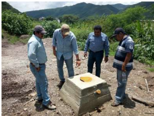
Perforación de pozo a 120 m de profundidad
