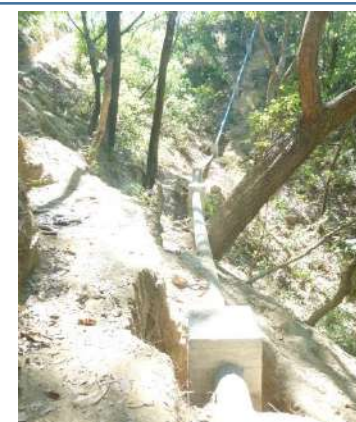
Línea de conducción de tubería de acero de 6" y atraques.
