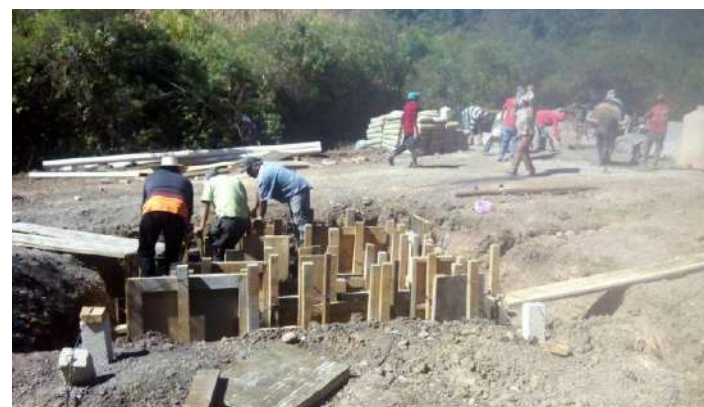
Cimbrado en tanques de contacto de cloro para conjunto en fosas.
