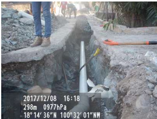
Instalación de tubería PVC de 6" en la red de distribución.
