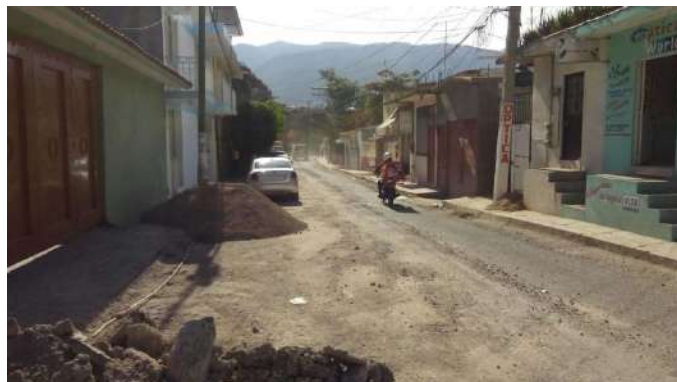
Reposición de pavimento en la red de distribución.
