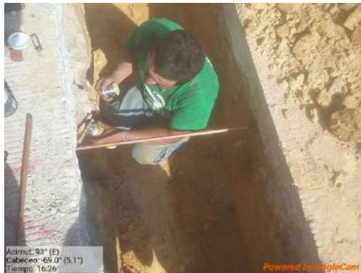
Línea de conducción instalación de tubería de PVC.
