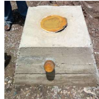
Perforación de pozo a 120 m de profundidad, gasto de 18 lps.
