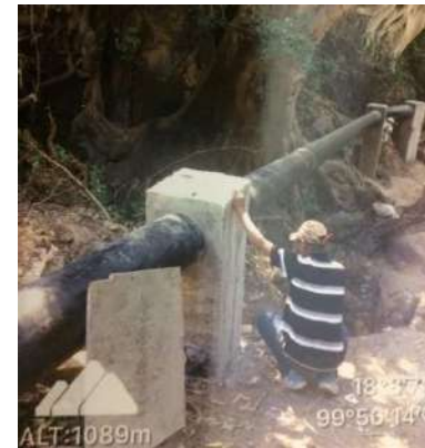
Colocación de tubería de acero y atraques.
