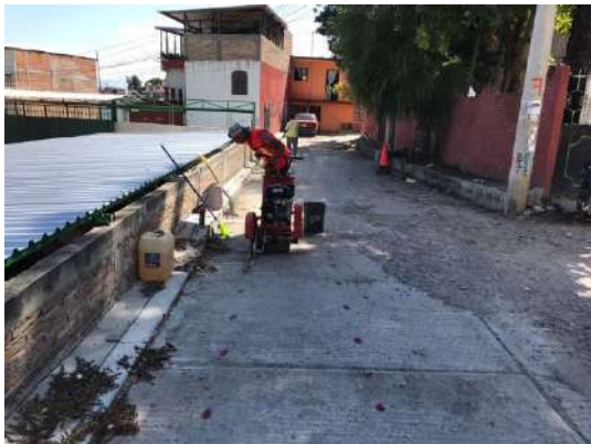
Trazo y corte en concreto hidráulico.
