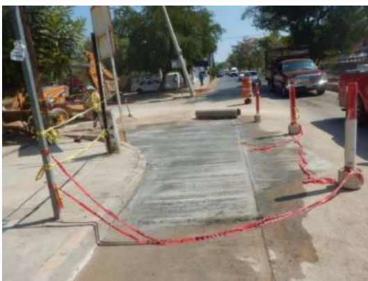
Interconexión de líneas de conducción.
