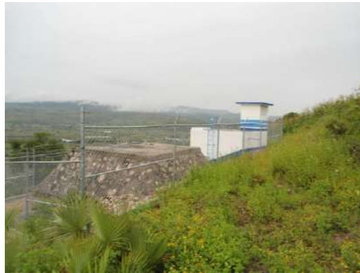
Tanque de regularización de 30 m3 y caseta de cloración.
