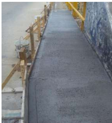
Reposición de concreto hidráulico en la línea de conducción.
