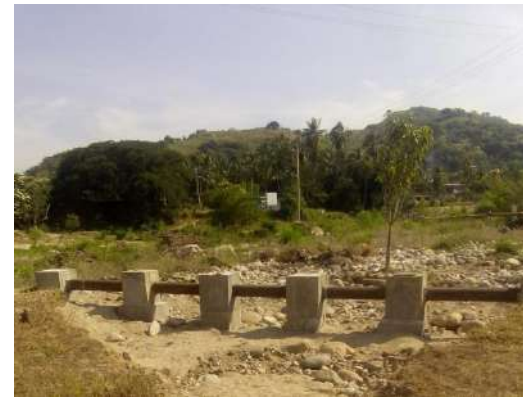
Línea de conducción instalación de tubería de acero y atraques.
