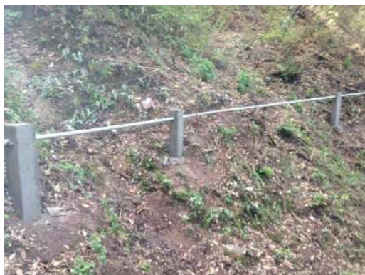
Línea de conducción instalación de tubería Fo.Go. de 1 1/2".
