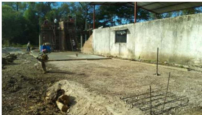
Construcción del tanque.
