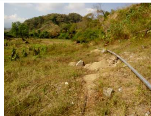
Instalación de tubería de Fo.Go. y construcción de atraques.
