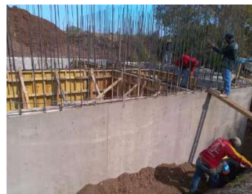
Rellenos en las estructuras de la PTAR.
