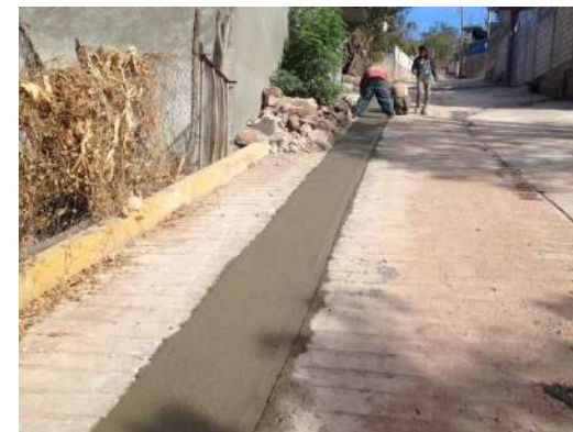
Reposición de concreto por la instalación de tubería.
