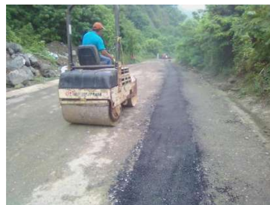
Reposición de pavimento en la red de atarjeas.
