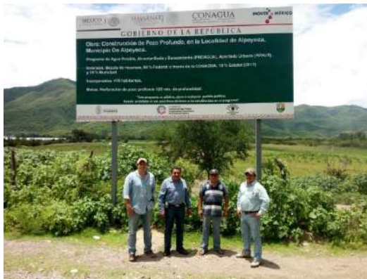
Perforación de pozo a 120 m de profundidad
