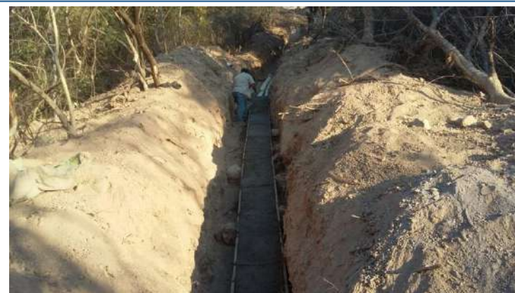
Encofrado de tubería PVC en la línea de conducción.
