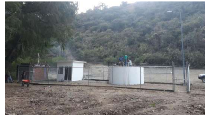
Caseta de controles y galería.
