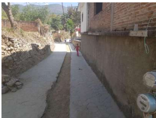
Relleno y compactación en la red de distribución.
