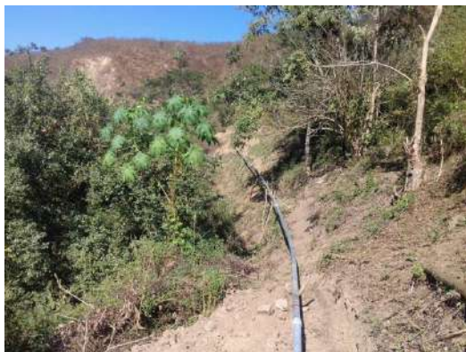
Línea de conducción instalación de tubería Fo.Go.
