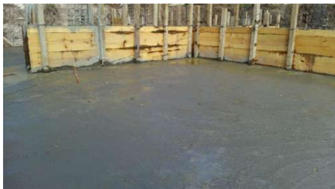
Construcción del tanque.
