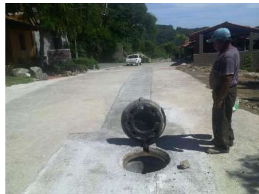
Reposición de pavimento en la red de atarjeas y pozos de visita.
