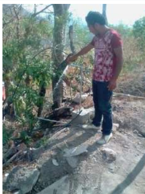
Prueba de tomas domiciliarias.
