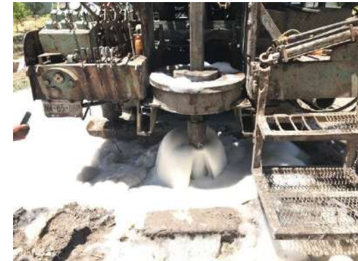
Limpeza del pozo.
