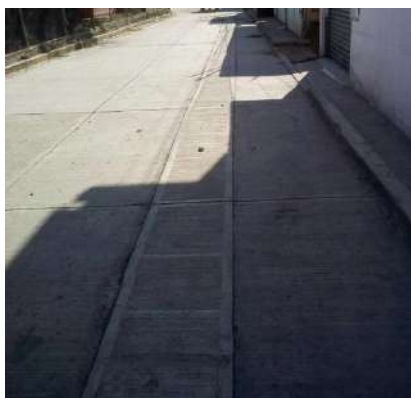
Reposición de pavimento hidráulico en la red de distribución.
