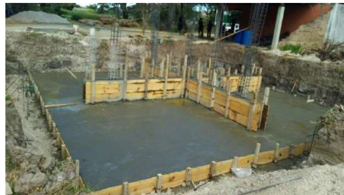
Construcción del tanque.
