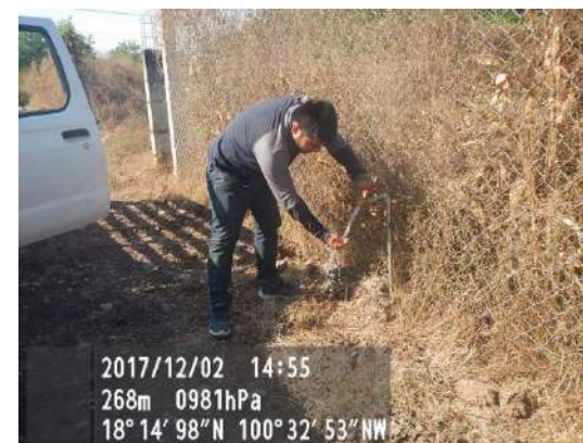
Prueba de tomas domiciliarias.
