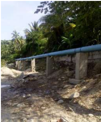
Línea de conducción instalación de tubería de acero y atraques.
