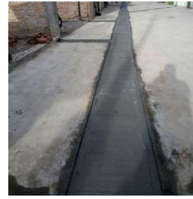
Reposición de concreto en la línea de conducción.
