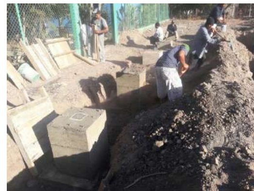
Cimentación de estructuras para el sistema fotovoltaico.
