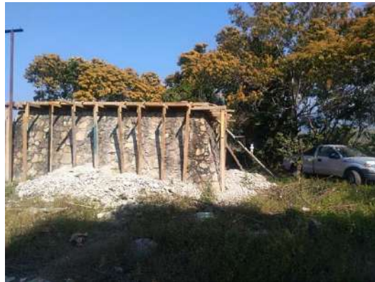
Rehabilitación de tanque de regularización de 100 m3.
