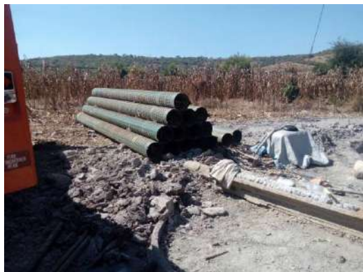
Tubería de acero ranurada para ademe del pozo.
