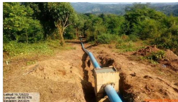
Línea de conducción instalación de tubería de acero de 6" y atraques.
