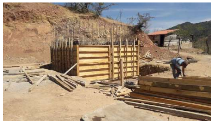
Construcción del tanque de 50 m3.
