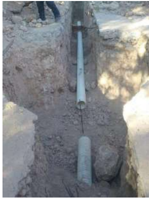
Instalación de tubería de PVC en la red de atarjeas.
