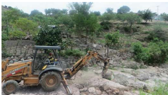
Maquinaria para inicio de los trabajos.
