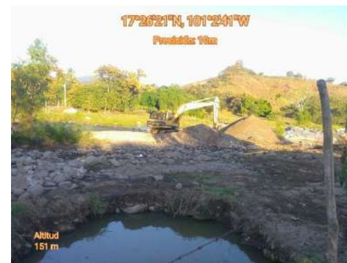
Excavación para construcción de la Obra de captación.
