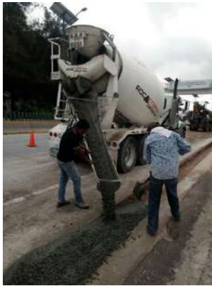
Reposición de concreto en la línea de conducción.
