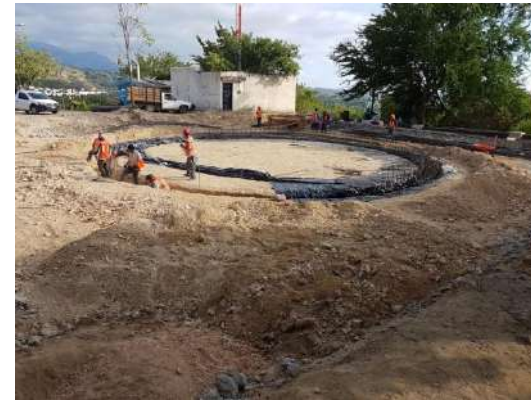
Estructura de cimentación para la colocación del tanque de almacenamiento para 1,200,000 lt.
