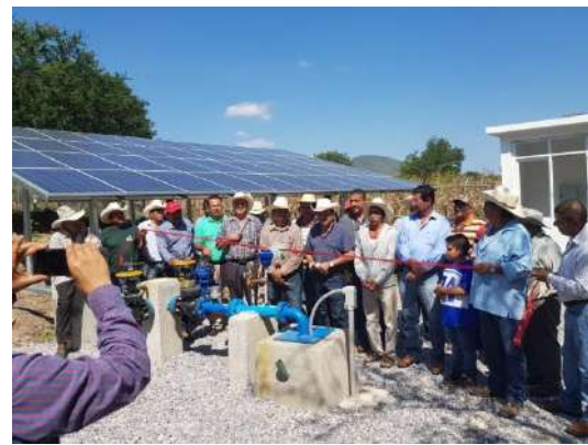
Celdas solares, caseta de controles y cerco de protección.
