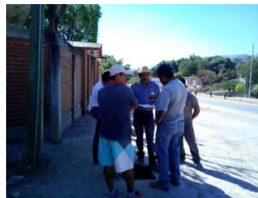
Cajas para operación de válvulas.
