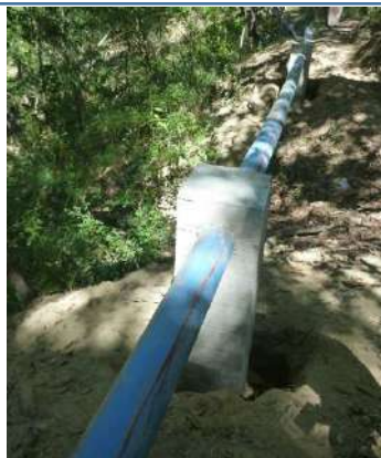
Línea de conducción de tubería de acero de 6" y atraques.
