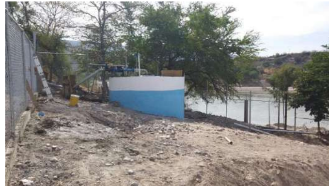
Pozo de inspección.
