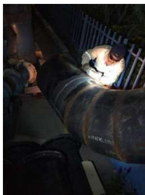
Línea de conducción al hospital, instalación de tubería de acero de 8".
