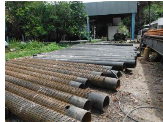
Tubería de acero para ademe del pozo.
