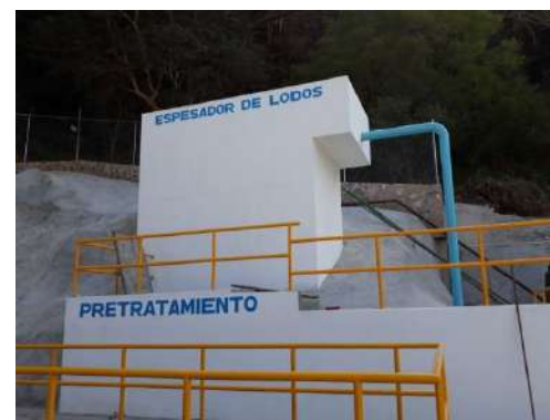
Estructura de PTAR.
