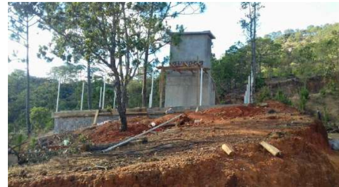
Tanque de regularización de 10 m3, caseta de cloración y cercado perimetral.
