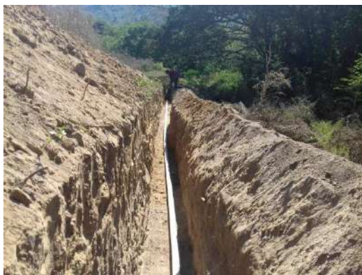
Línea de conducción instalación de tubería PVC
