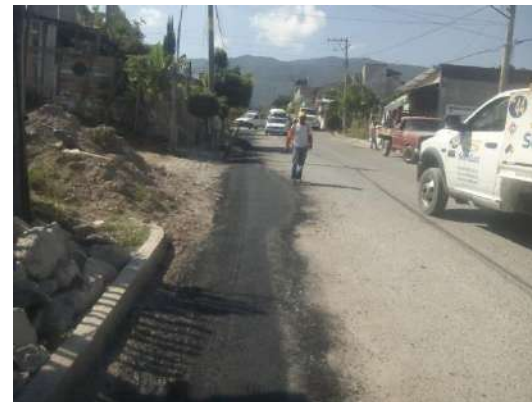
Reposición de pavimento en la red de distribución.
