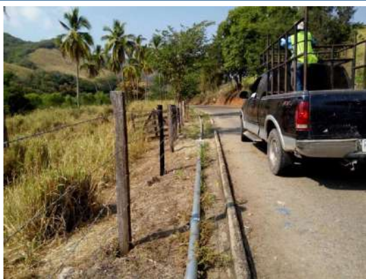
Instalación de tubería de Fo.Go.
