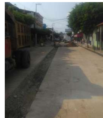
Relleno y compactación en el colector.
