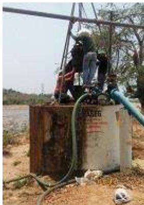
Rehabilitación de equipamiento.
