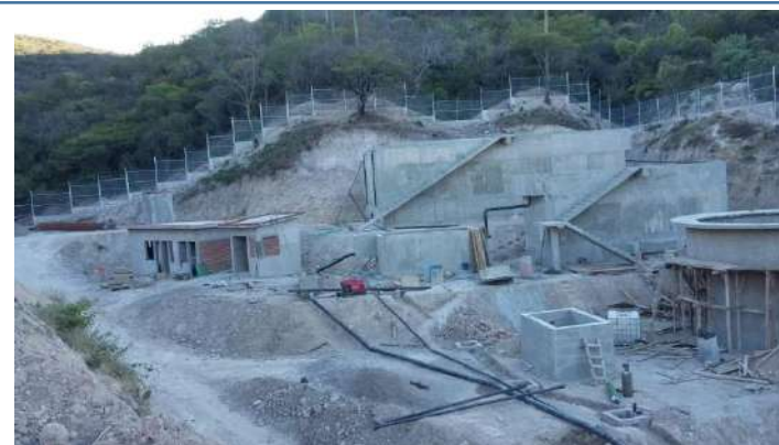
Obra civil de la PTAR.
