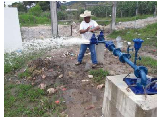
Prueba del tren de descarga.
