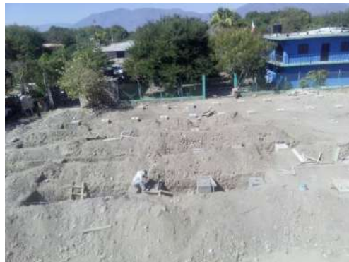
Cimentación de estructuras para el sistema fotovoltaico.
