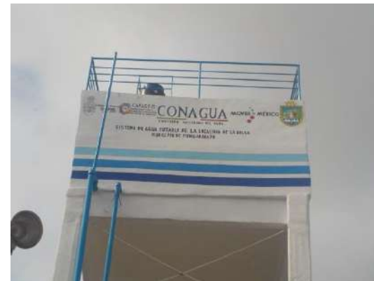
Rehabilitación de tanque de regulación (elevado).
