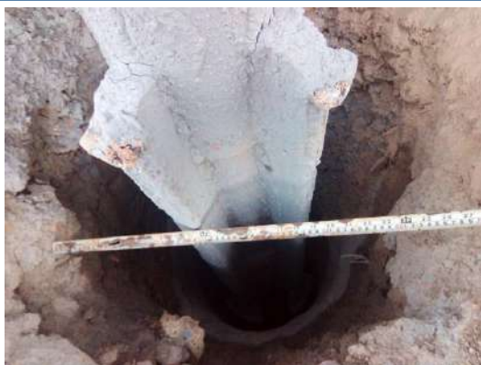
Perforación de pozo.
