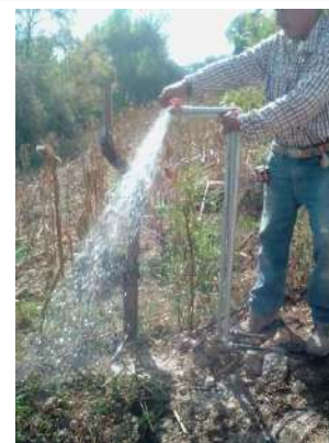
Prueba de tomas domiciliarias.
