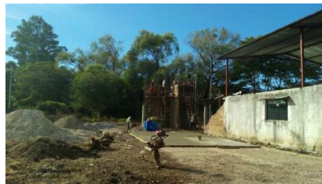
Construcción del tanque.
