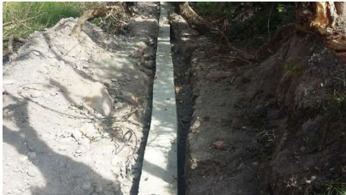
Encofrado de tubería en el colector.
