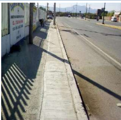
Reposición de pavimento hidráulico en la red de distribución.
