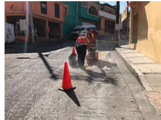
Corte en concreto hidráulico.
