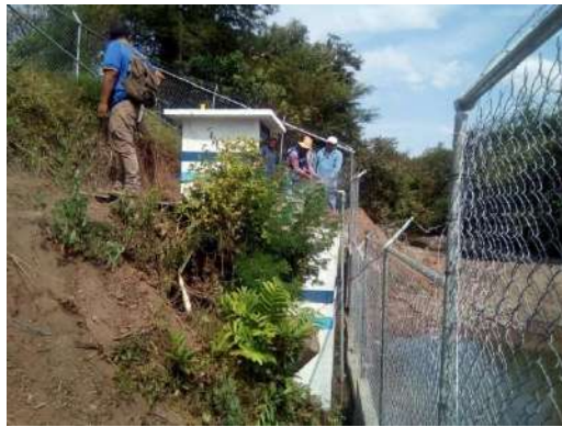
Tanque de regularización de 25 m3.
