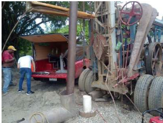
Preparación para videograbación del pozo.
