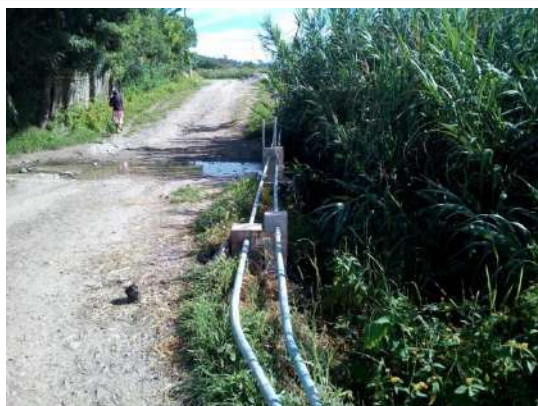
Línea de conducción de tubería Fo.Go.
