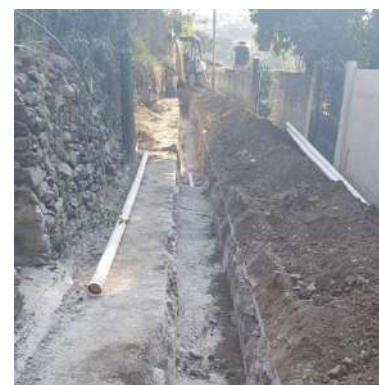
Red de distribución instalación de tubería PVC.
