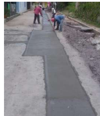
Reposición de concreto en la red de distribución.
