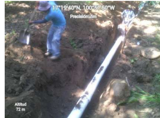
Línea de conducción instalación de tubería PVC de 8\"/>
