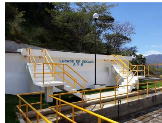
Estructura de PTAR.
