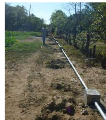
Red de distribución instalación de tubería Fo.Go.
