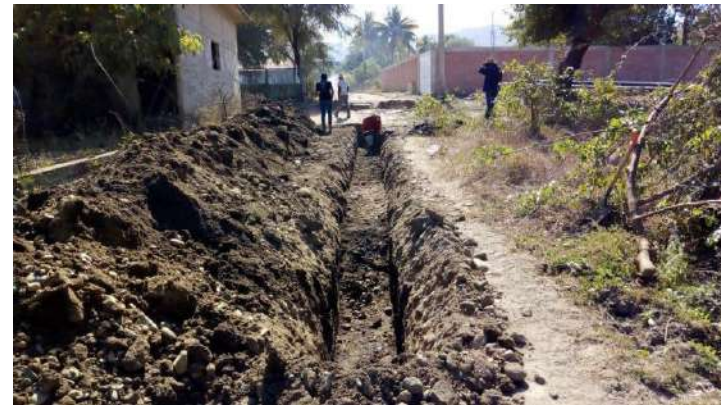
Relleno y compactación en la instalación de tubería en red de atarjeas.
