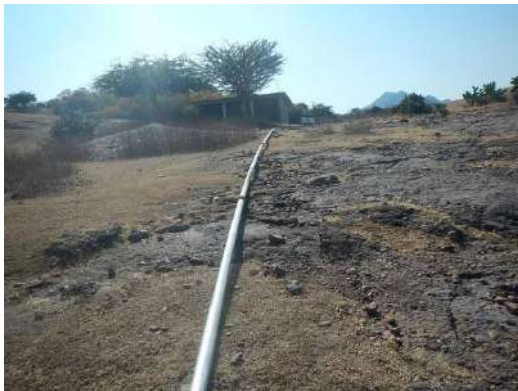
Línea de conducción instalación de tubería Fo.Go. de 2".
