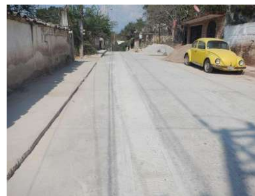
Reposición de concreto en red distribución e Instalación de tubería PVC.
