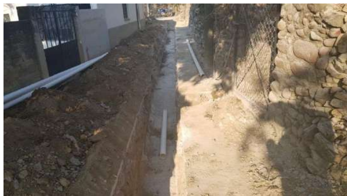
Red de distribución instalación de tubería PVC.
