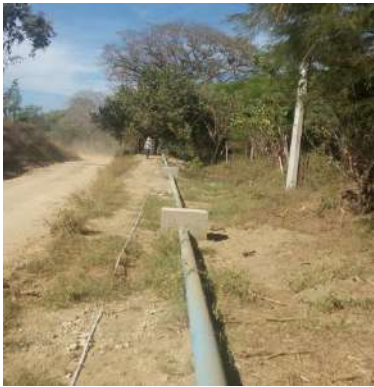
Línea de conducción de tubería de acero de 6" y atraques.
