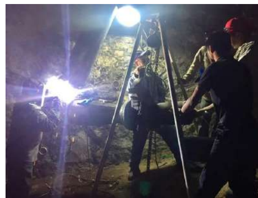
Línea de conducción al hospital, instalación de tubería de acero de 8".
