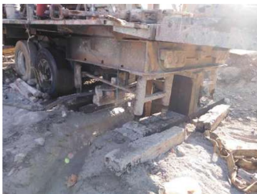
Perforación de pozo.
