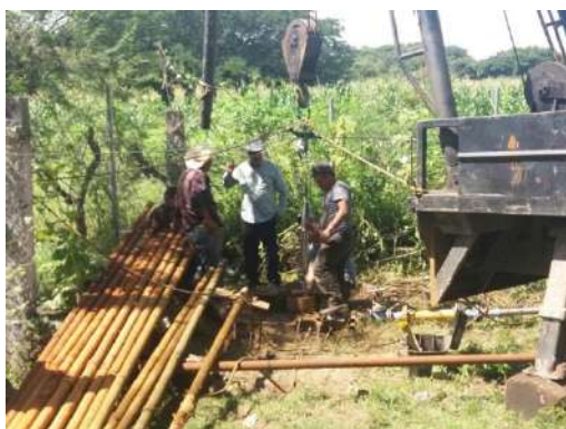
Perforación de pozo.
