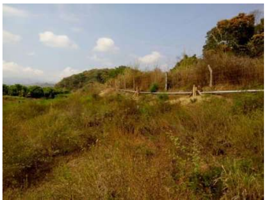
Instalación de tubería de Fo.Go. y construcción de atraques.
