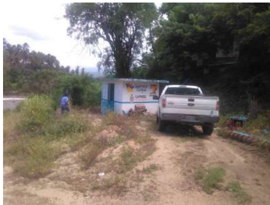
Galería de captación
