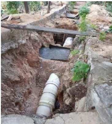
Rehabilitación línea de conducción instalación de tubería PVC de 18".
