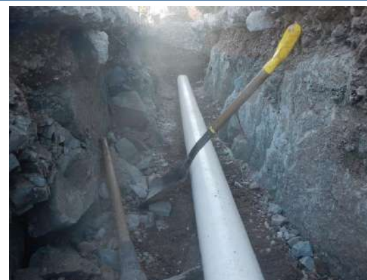
Instalación de tubería PVC de 6" en la red de distribución.
