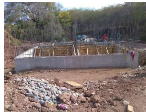
Colado en las estructuras de la PTAR.
