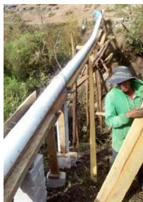
Instalación de tubería PVC en la red de atarjeas.
