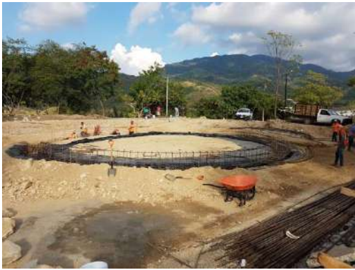
Estructura de cimentación para la colocación del tanque de almacenamiento para 1,200,000 lt.
