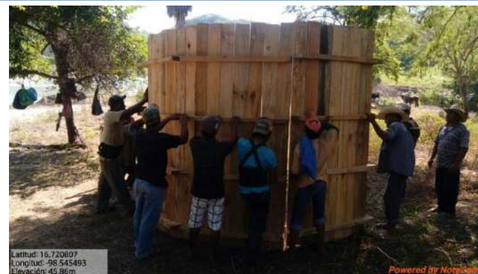
Cimbra para galería filtrante.
