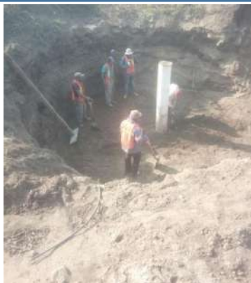
Perforación de pozo profundo.
