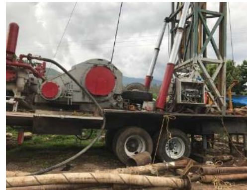
Perforación de pozo.
