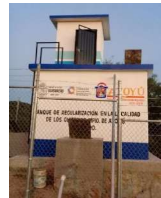
Tanque de regularización de 14 m3 con cerco perimetral y caseta de cloración.
