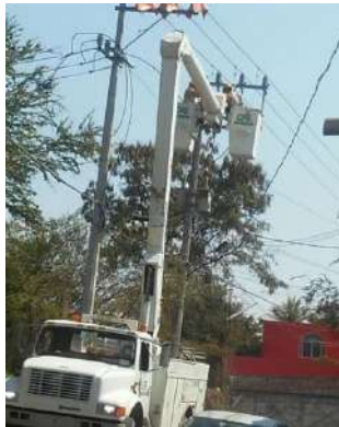
Instalación de electricidad.
