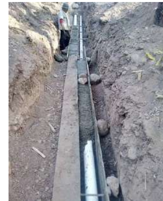
Línea de conducción encofrado de tubería PVC de 6".
