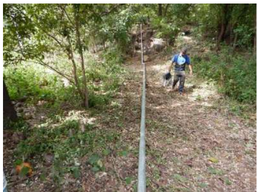
Línea de conducción instalación de tubería Fo.Go. de 3"
