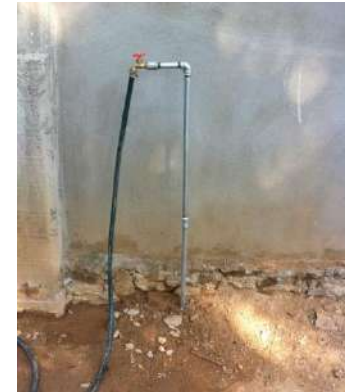
Red de distribución instalación de tubería Fo.Go.
