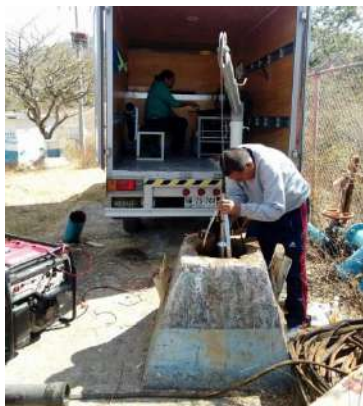
Instalación de equipo para videograbación del pozo.
