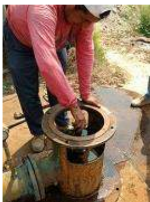
Rehabilitación de equipamiento.
