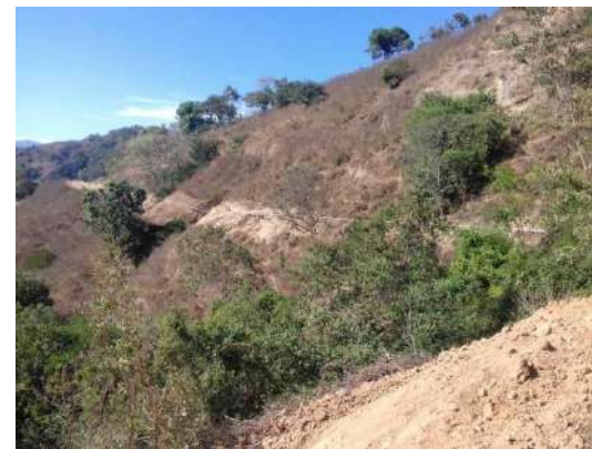
Línea de conducción instalación de tubería Fo.Go.
