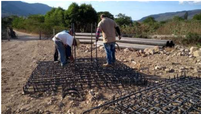
Armado para cruce de la tubería de acero del colector en el río.
