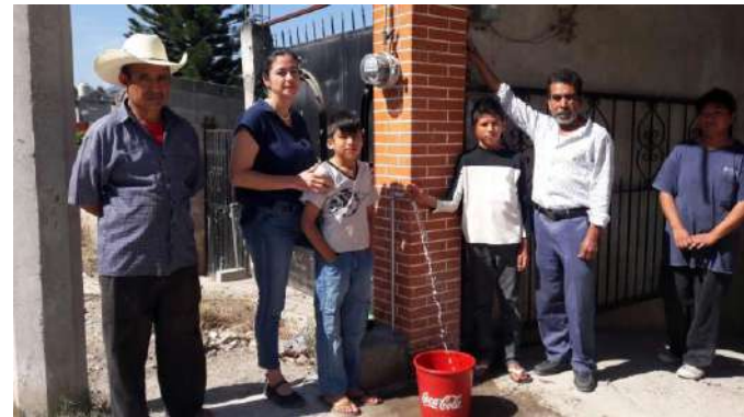
Prueba de red de distribución y tomas domiciliarias.
