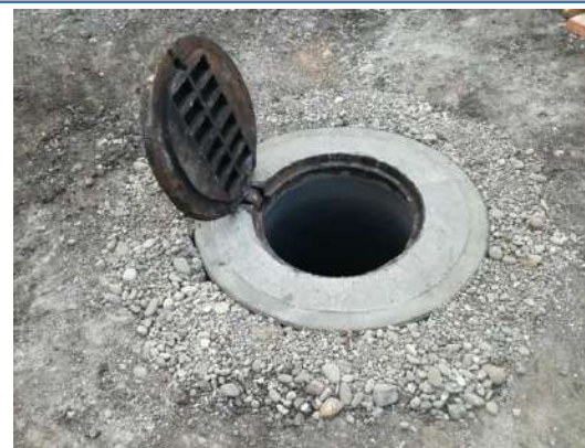
Pozos de visita en la red de atarjeas.
