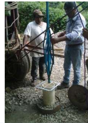
Preparación para videograbación del pozo.
