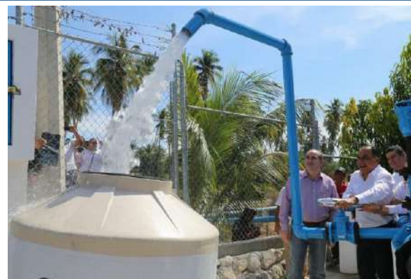
Prueba de planta potabilizadora.
