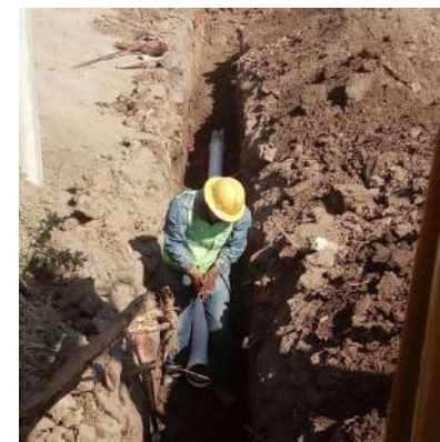
Red de distribución instalación de tubería PVC.
