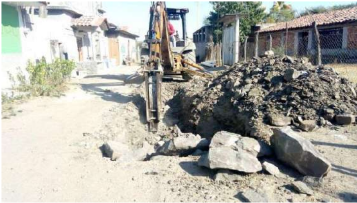
Excavación para instalación de tubería en red de atarjeas.
