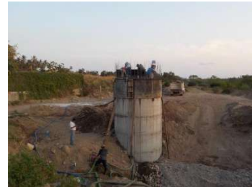
Galería filtrante horizontal.
