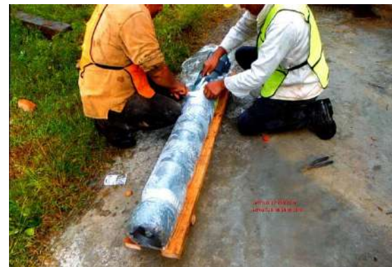
Rehabilitación del equipo de bombeo.
