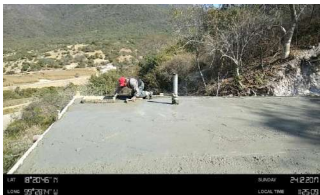
Colado de la losa del tanque.
