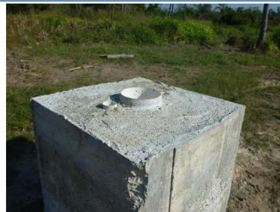
Perforación de Pozo a 20 m de profundidad.
