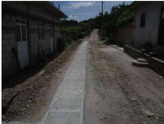
Reposición de concreto en la red de distribución.
