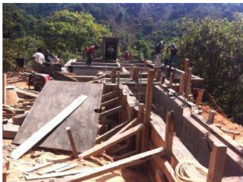
Rehabilitación del pretratamiento y bioreactor existente.
