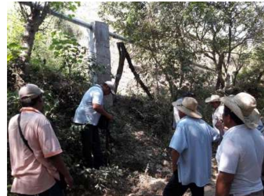
Línea de conducción de tubería Fo.Go.y atraques.
