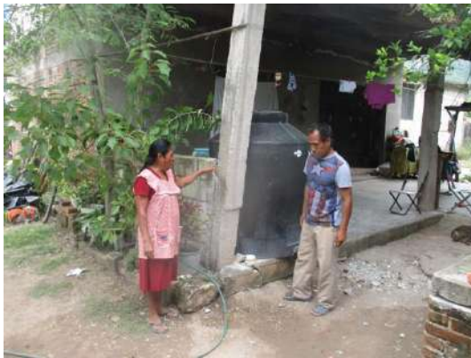
Prueba de tomas domiciliarias.
