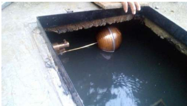
Llenado del tanque.
