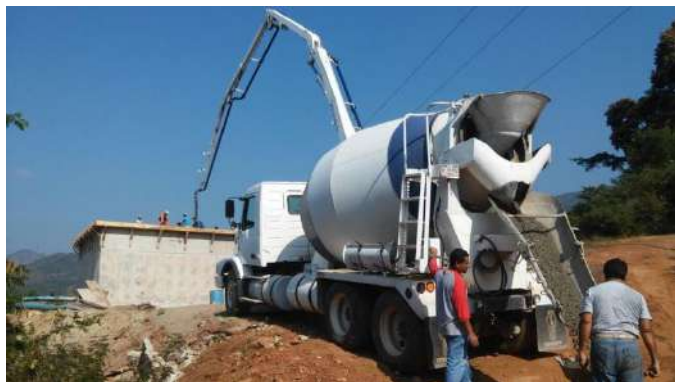
Colado del tanque.
