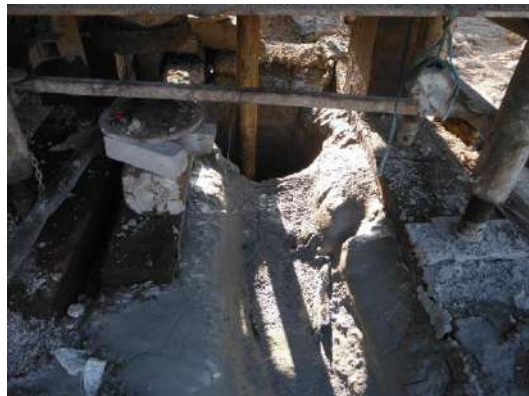
Perforación de pozo.
