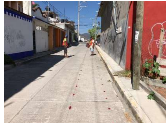
Trazo y corte en concreto hidráulico.
