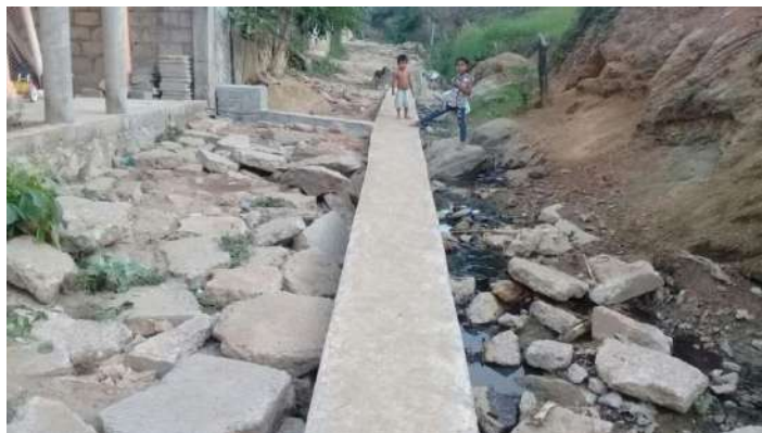
Encofrado en la red de atarjeas.
