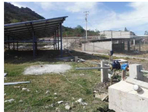
Interconexión con el pozo existente.
