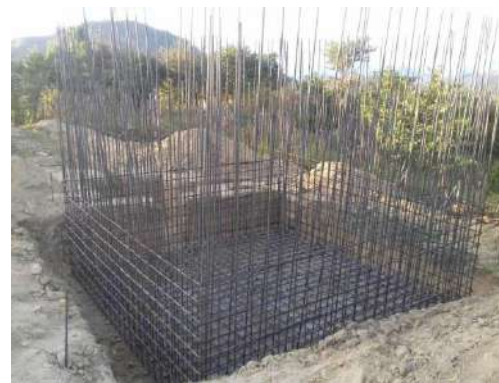
Estructura de tanque de regularización de 20 m 3 .
