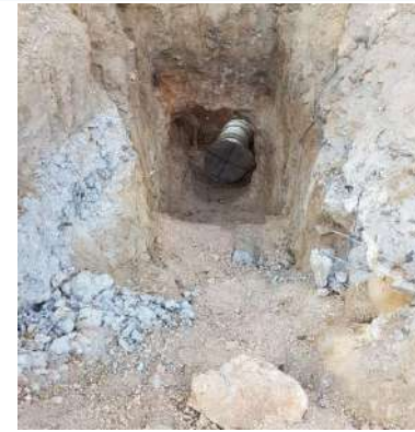
Rehabilitación línea de conducción instalación de tubería PVC de 18".
