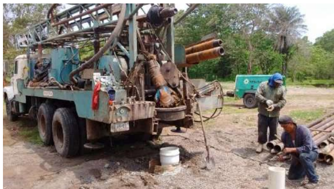
Perforación de pozo profundo.
