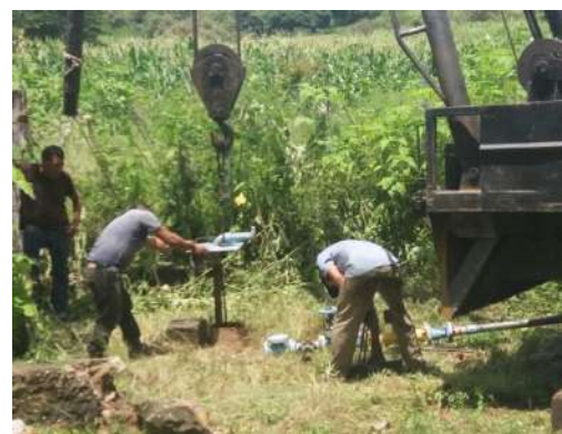
Perforación de pozo. No aportó gasto requerido.
