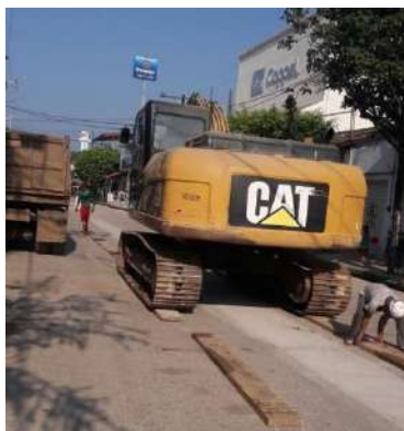
Reposición de concreto hidráulico en el colector.
