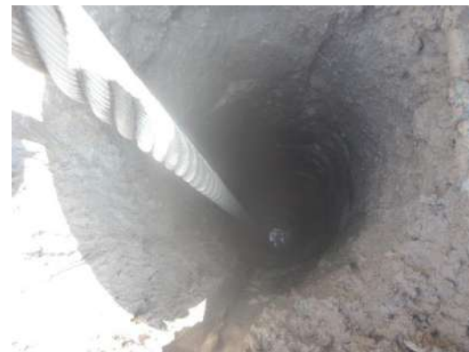
Perforación del pozo.
