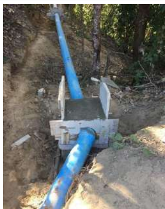
Línea de conducción de tubería de acero de 6" y atraques.
