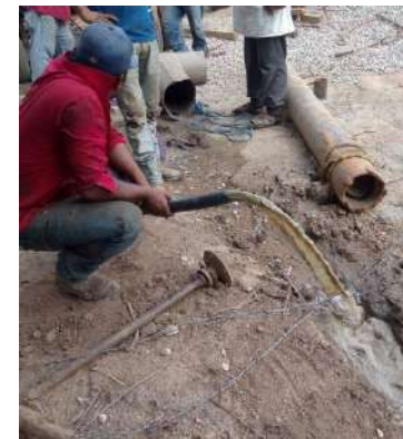
Aforo del pozo, no aportó gasto requerido por la localidad.
