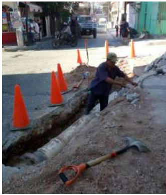
Línea de conducción tubería PVC.
