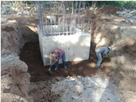
Colado del cárcamo de bombeo en red de atarjeas.
