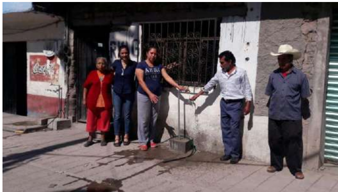
Prueba de red de distribución y tomas domiciliarias.
