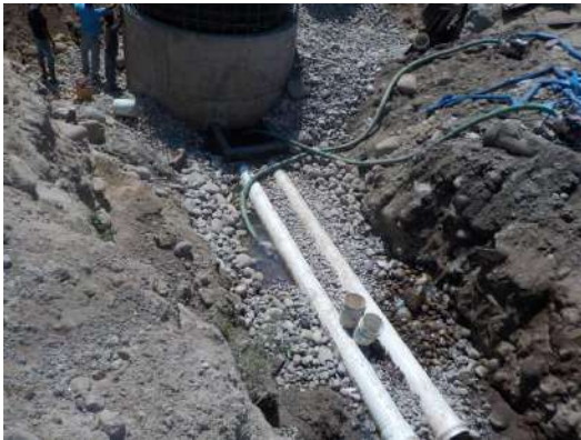
Galería filtrante horizontal.
