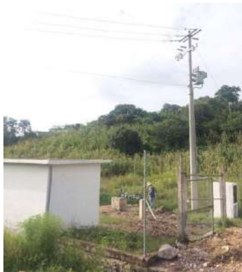
Rehabilitación de pozo profundo y equipamiento electromecánico.
