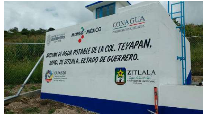
Tanque de regularización de 30 m3 y caseta de cloración.
