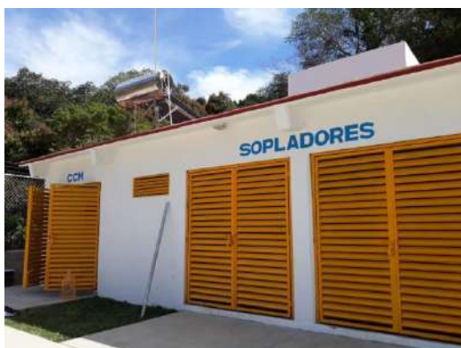
Estructura de PTAR.
