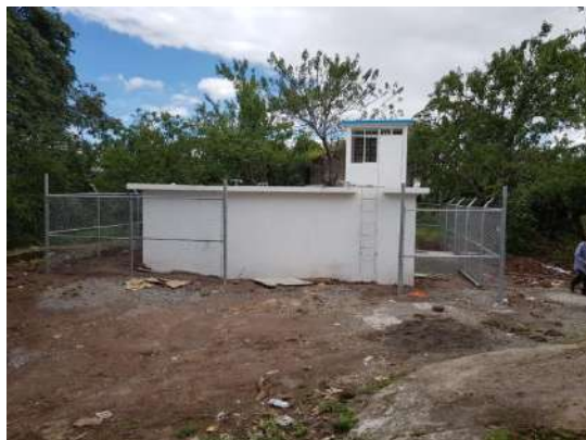
Tanque de regularización de 100 m3.
