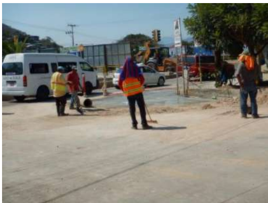
Interconexión de líneas de conducción.
