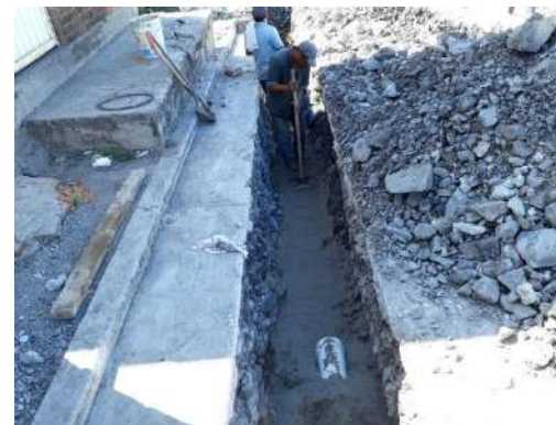
Relleno y compactación en la red de distribución.
