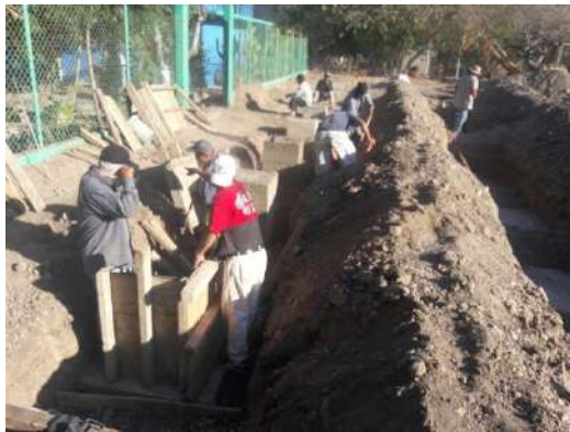
Cimentación de estructuras para el sistema fotovoltaico.
