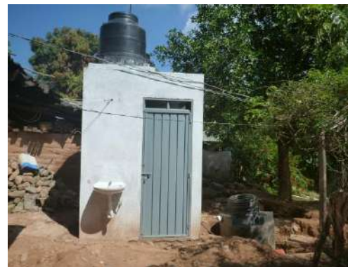
Sanitario digno con biodigestor.
