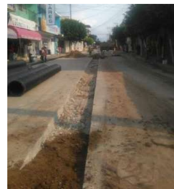
Relleno y compactación en el colector.
