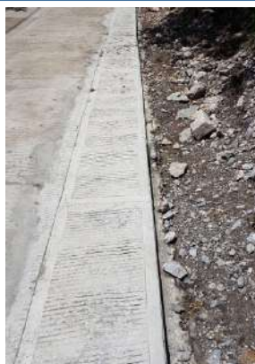
Reposición de concreto hidráulico en la red de distribución.
