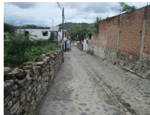
Reposición de empedrado en la red de distribución.
