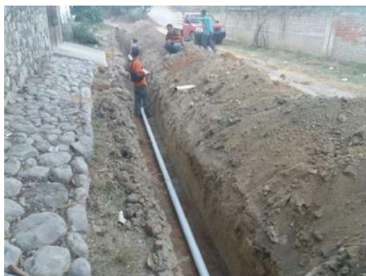
Instalación de tubería PVC en la red de distribución.
