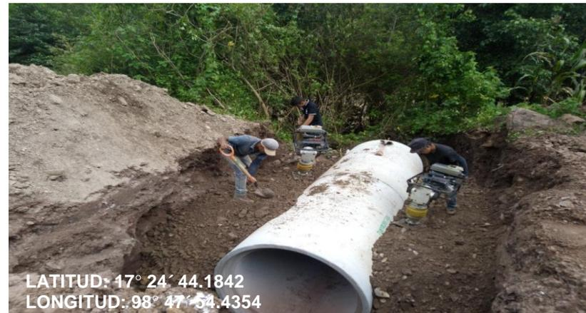
COLOCACION DEL TUBO DE CONCRETO DE 1.20 CMS DE DIAMETRO KM. 1+560
