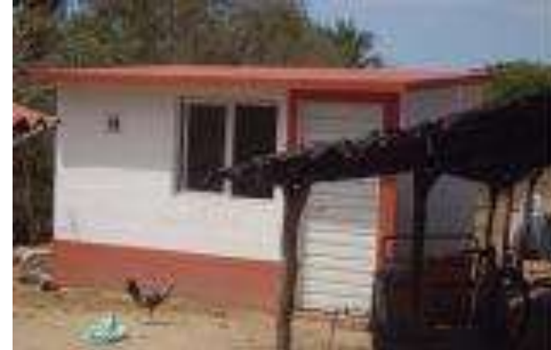
Cuarto Dormitorio Terminado.
