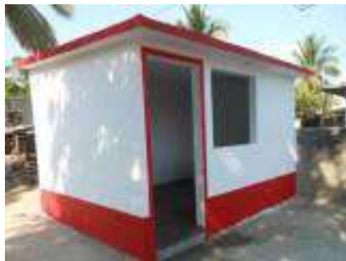
Albañilería (Levantamientos de muros, colado de loza y/o Pintura y acabados.)
