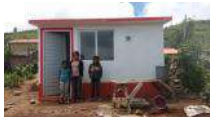
Cuarto Dormitorio Terminado.
