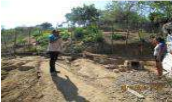
Trazo, excavación y/o desplantes del Cuarto Dormitorio.
