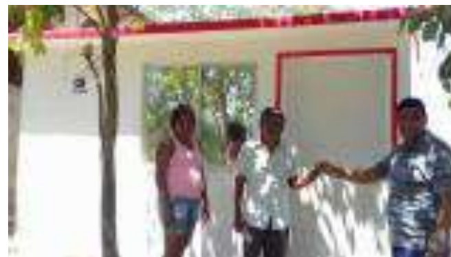
Cuarto Dormitorio Terminado.
