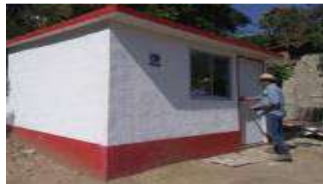
Cuarto Dormitorio Terminado.
