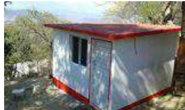
Cuarto Dormitorio Terminado.
