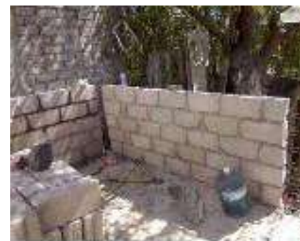
Albañilería (Levantamientos de muros y/o colado de loza)
