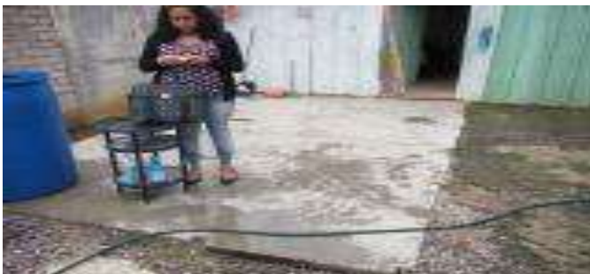
Trazo, excavación y/o desplantes del Cuarto Dormitorio.
