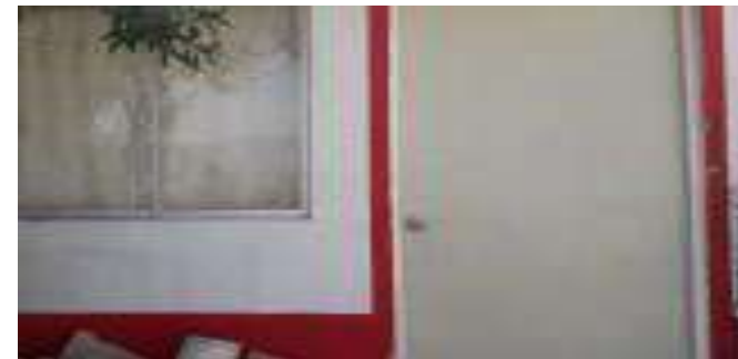
Cuarto Dormitorio Terminado.
