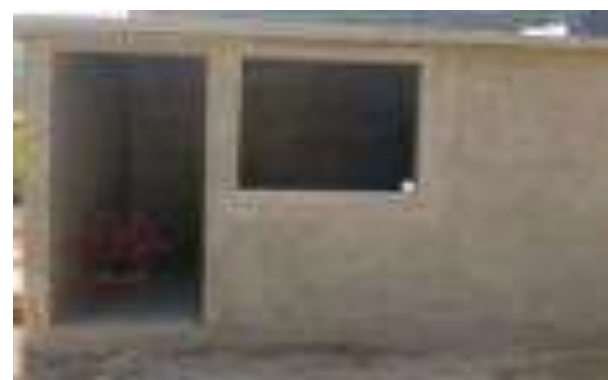
Albañilería (Levantamientos de muros y/o colado de loza)
