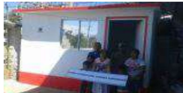
Cuarto Dormitorio Terminado.
