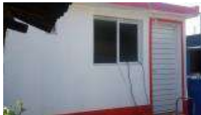
Cuarto Dormitorio Terminado.
