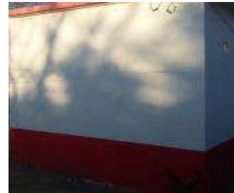
Cuarto Dormitorio Terminado.
