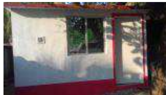
Cuarto Dormitorio Terminado.
