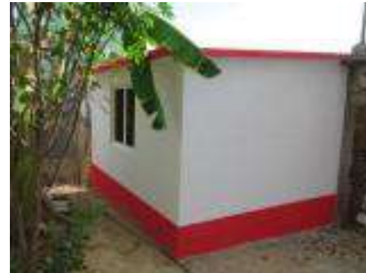
Cuarto Dormitorio Terminado.
