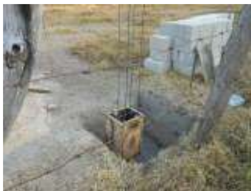
Trazo, excavación y/o desplantes del Cuarto Dormitorio.
