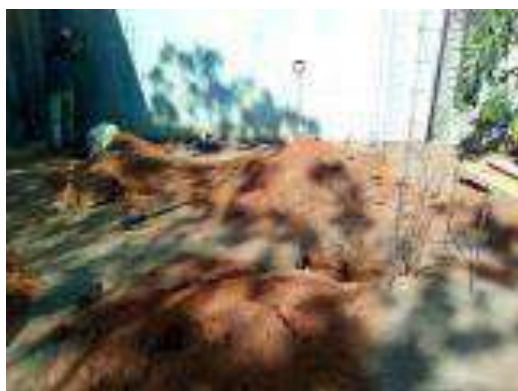
Trazo, excavación y/o desplantes del Cuarto Dormitorio.
