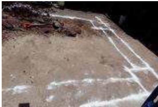
Trazo, excavación y/o desplantes del Cuarto Dormitorio.
