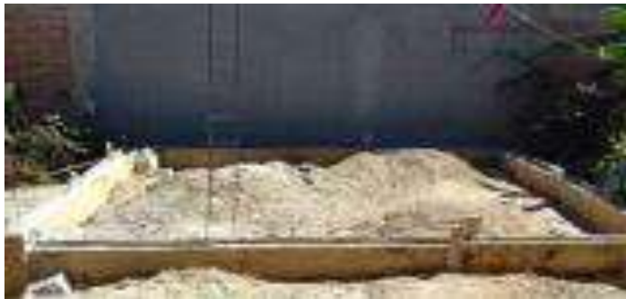
Trazo, excavación y/o desplantes del Cuarto Dormitorio.
