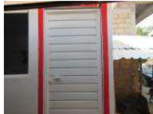
Cuarto Dormitorio Terminado.
