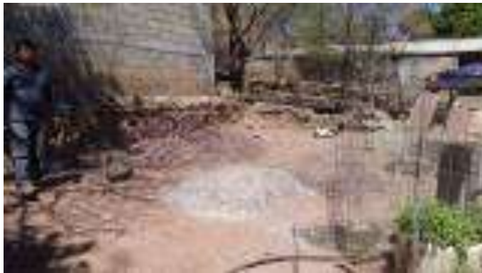
Trazo, excavación y/o desplantes del Cuarto Dormitorio.
