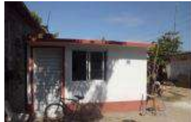
Cuarto Dormitorio Terminado.
