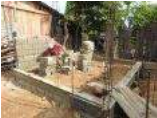
Trazo, excavación y/o desplantes del Cuarto Dormitorio.
