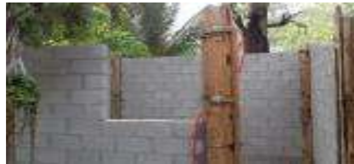
Albañilería (Levantamientos de muros y/o colado de loza)
