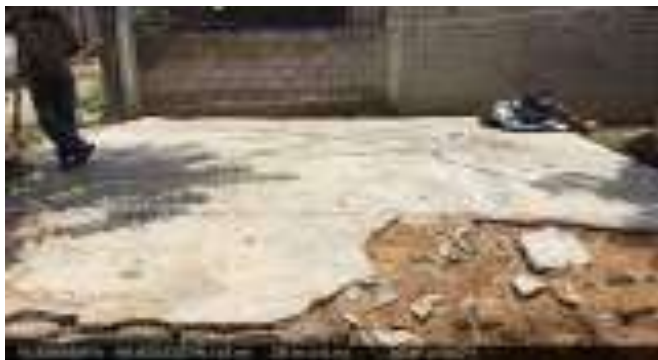
Trazo, excavación y/o desplantes del Cuarto Dormitorio.
