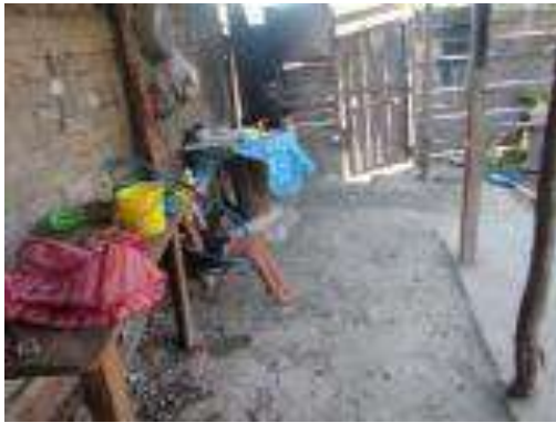
Trazo, excavación y/o desplantes del Cuarto Dormitorio.
