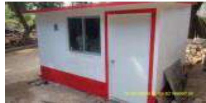
Cuarto Dormitorio Terminado.
