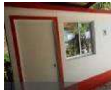
Cuarto Dormitorio Terminado.
