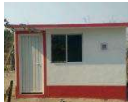
Cuarto Dormitorio Terminado.
