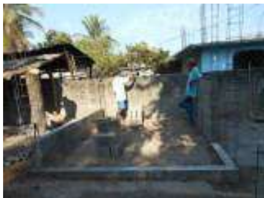
Trazo, excavación y/o desplantes del Cuarto Dormitorio.
