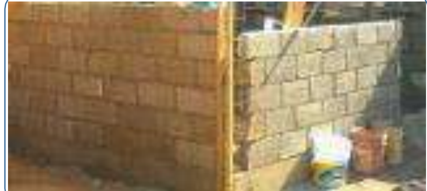
Albañilería (Levantamientos de muros y/o colado de loza)
