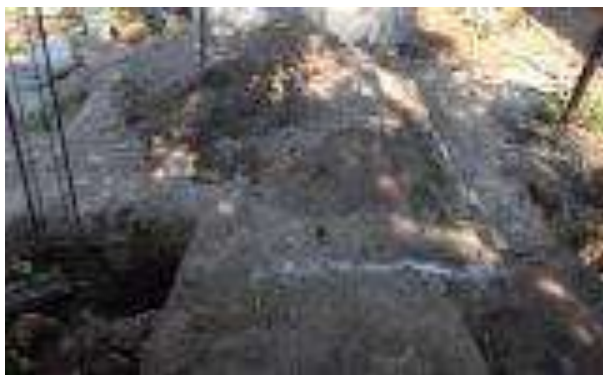
Trazo, excavación y/o desplantes del Cuarto Dormitorio.
