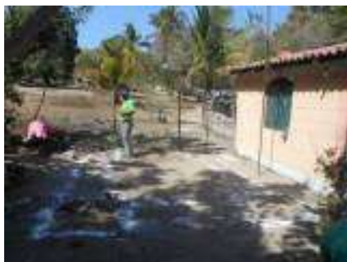
Trazo, excavación y/o desplantes del Cuarto Dormitorio.
