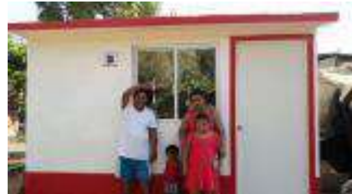
Cuarto Dormitorio Terminado.
