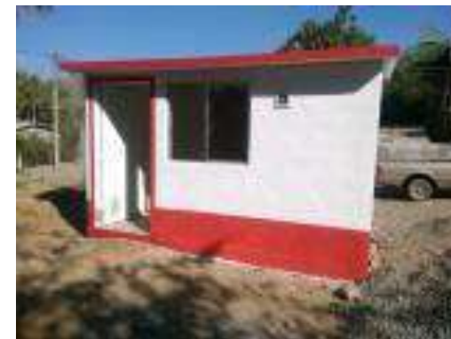
Cuarto Dormitorio Terminado.
