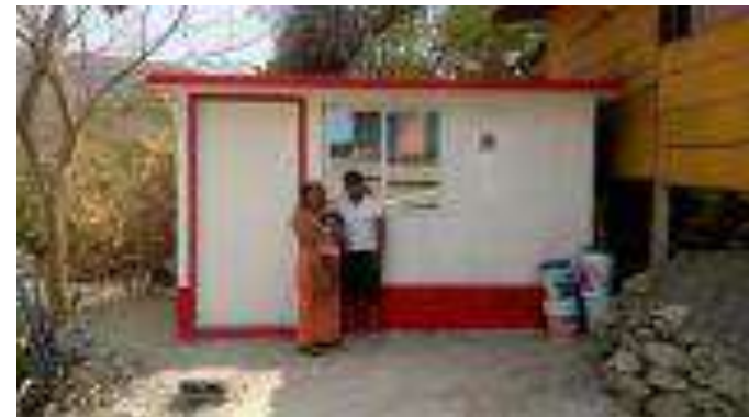
Cuarto Dormitorio Terminado.
