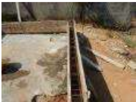
Trazo, excavación y/o desplantes del Cuarto Dormitorio.
