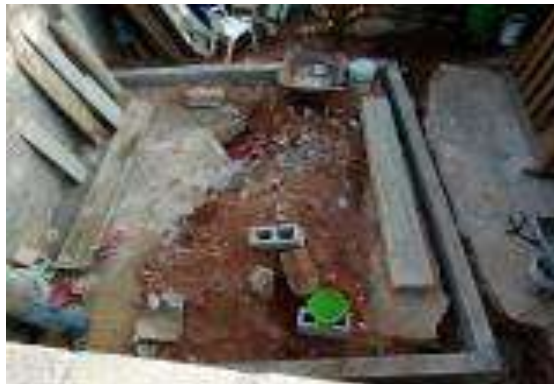
Trazo, excavación y/o desplantes del Cuarto Dormitorio.
