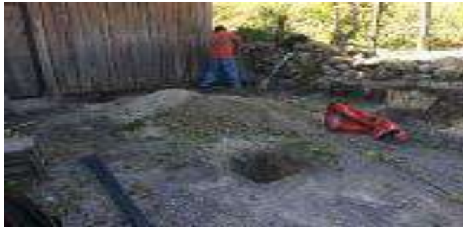
Trazo, excavación y/o desplantes del Cuarto Dormitorio.
