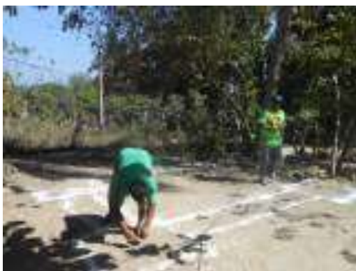
Trazo, excavación y/o desplantes del Cuarto Dormitorio.
