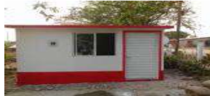
Cuarto Dormitorio Terminado.
