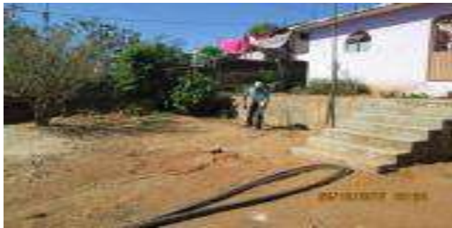
Trazo, excavación y/o desplantes del Cuarto Dormitorio.
