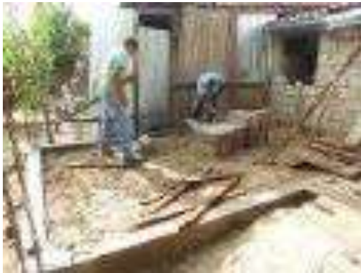
Trazo, excavación y/o desplantes del Cuarto Dormitorio.
