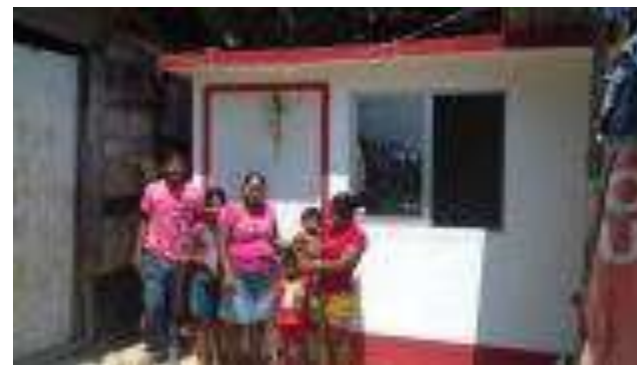
Cuarto Dormitorio Terminado.
