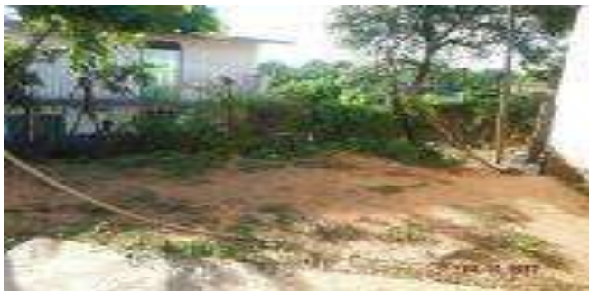
Trazo, excavación y/o desplantes del Cuarto Dormitorio.
