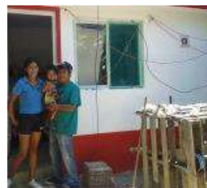
Cuarto Dormitorio Terminado.
