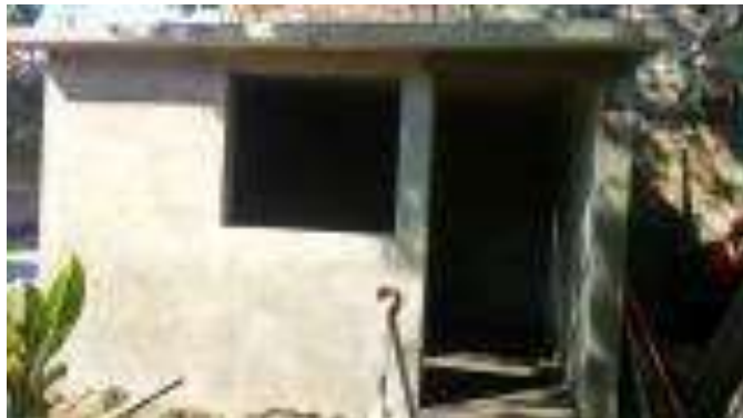
Albañilería (Levantamientos de muros y/o colado de loza)
