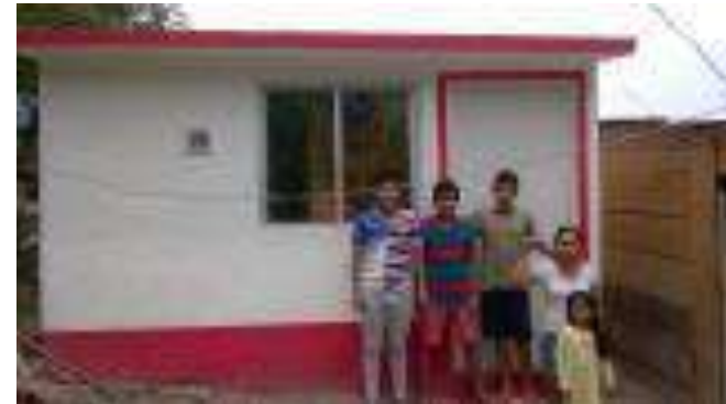
Cuarto Dormitorio Terminado.
