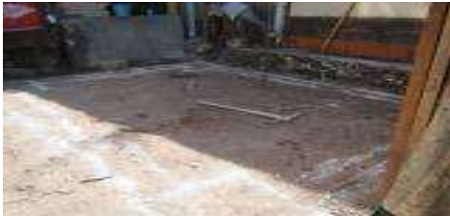
Trazo, excavación y/o desplantes del Cuarto Dormitorio.
