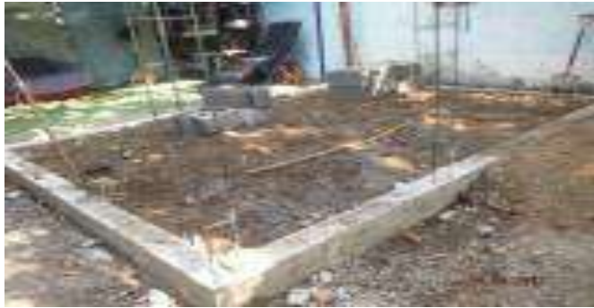
Trazo, excavación y/o desplantes del Cuarto Dormitorio.
