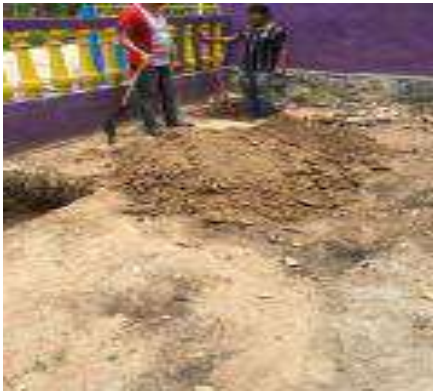
Trazo, excavación y/o desplantes del Cuarto Dormitorio.
