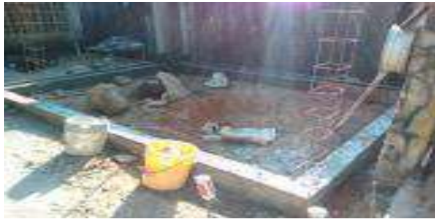
Trazo, excavación y/o desplantes del Cuarto Dormitorio.
