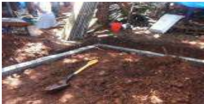
Trazo, excavación y/o desplantes del Cuarto Dormitorio.
