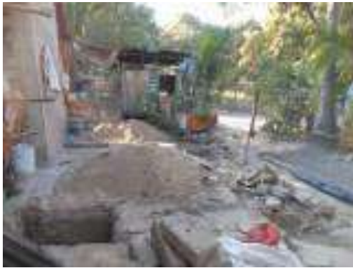
Trazo, excavación y/o desplantes del Cuarto Dormitorio.
