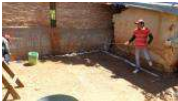
Trazo, excavación y/o desplantes del Cuarto Dormitorio.
