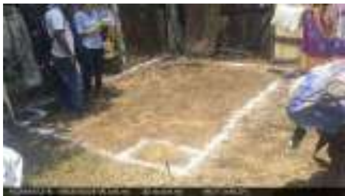
Trazo, excavación y/o desplantes del Cuarto Dormitorio.
