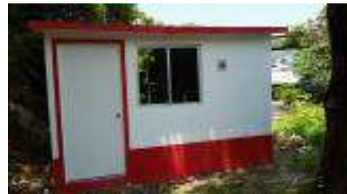
Cuarto Dormitorio Terminado.
