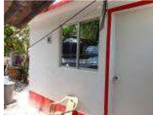
Cuarto Dormitorio Terminado.
