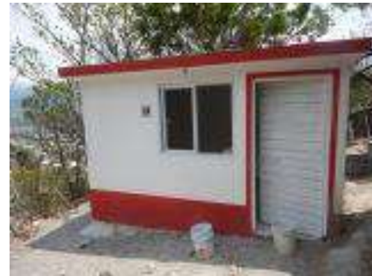
Cuarto Dormitorio Terminado.
