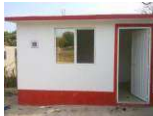
Cuarto Dormitorio Terminado.
