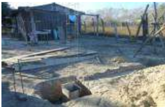
Trazo, excavación y/o desplantes del Cuarto Dormitorio.
