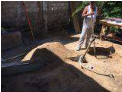
Trazo, excavación y/o desplantes del Cuarto Dormitorio.
