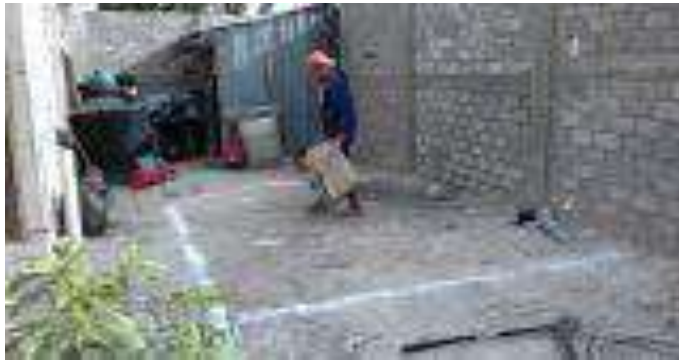
Trazo, excavación y/o desplantes del Cuarto Dormitorio.
