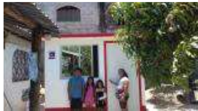
Cuarto Dormitorio Terminado.
