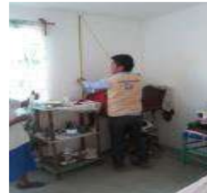
Cuarto Dormitorio Terminado.
