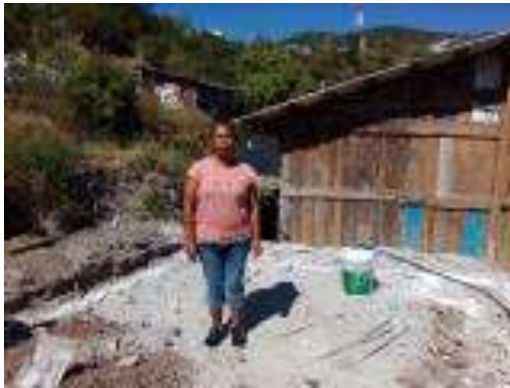
Trazo, excavación y/o desplantes del Cuarto Dormitorio.
