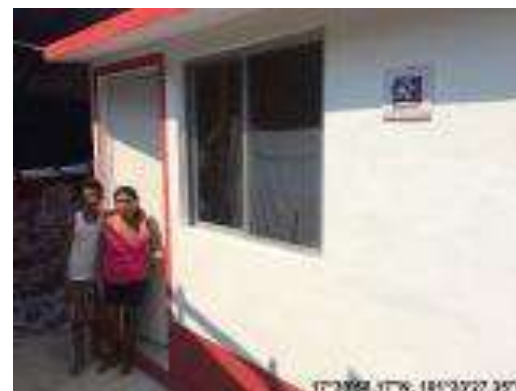
Cuarto Dormitorio Terminado.
