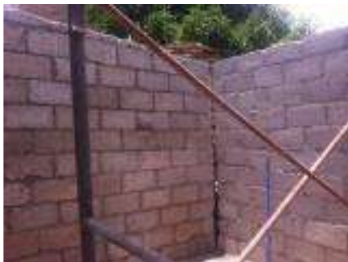
Albañería (Levantamientos de muros y/o colado de loza)
