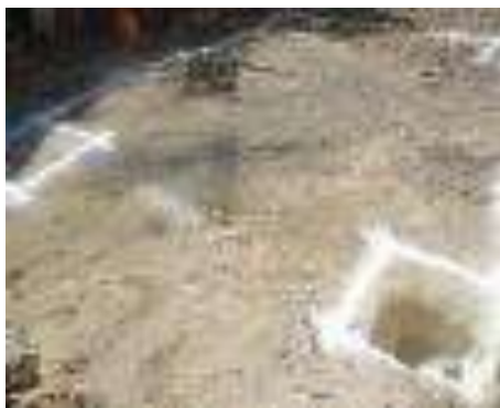
Trazo, excavación y/o desplantes del Cuarto Dormitorio.
