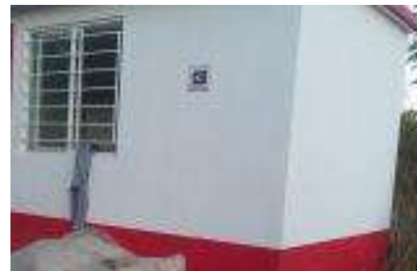
Cuarto Dormitorio Terminado.
