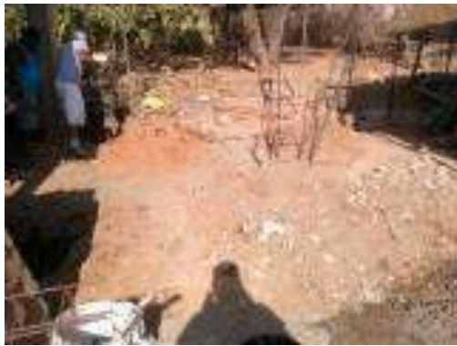
Trazo, excavación y/o desplantes del Cuarto Dormitorio.
