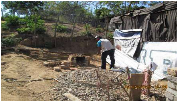
Trazo, excavación y/o desplantes del Cuarto Dormitorio.
