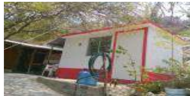
Cuarto Dormitorio Terminado.
