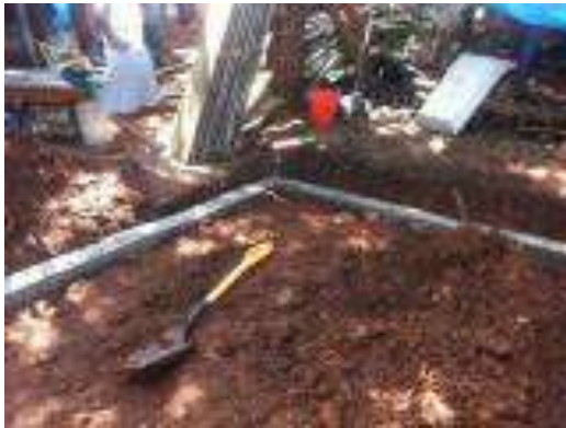
Trazo, excavación y/o desplantes del Cuarto Dormitorio.
