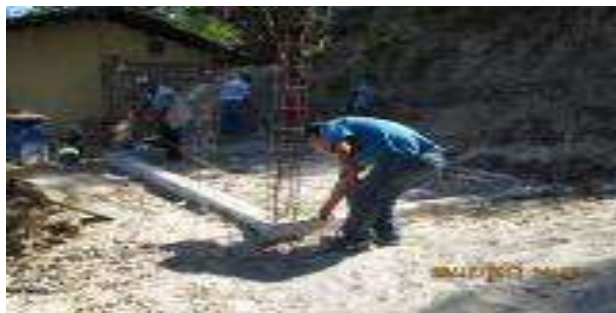
Trazo, excavación y/o desplantes del Cuarto Dormitorio.
