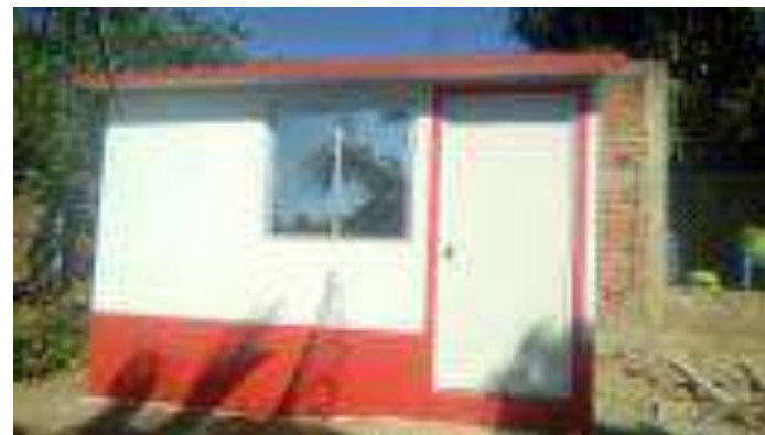
Cuarto Dormitorio Terminado.
