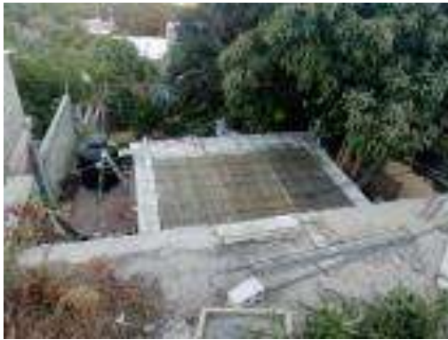
Trazo, excavación y/o desplantes del Cuarto Dormitorio.
