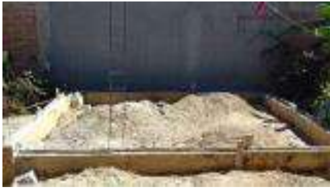
Trazo, excavación y/o desplantes del Cuarto Dormitorio.
