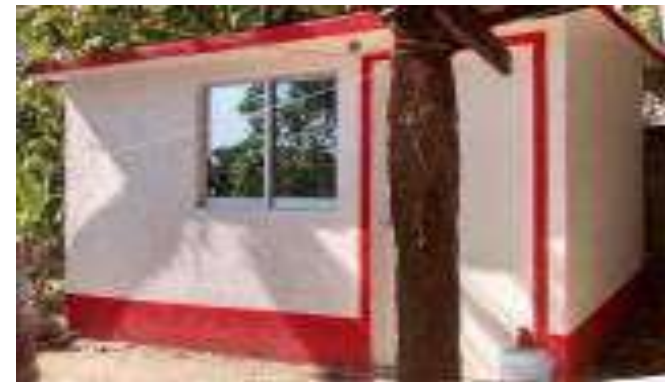
Cuarto Dormitorio Terminado.
