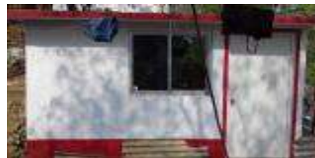
Cuarto Dormitorio Terminado.
