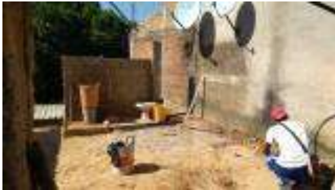
Trazo, excavación y/o desplantes del Cuarto Dormitorio.
