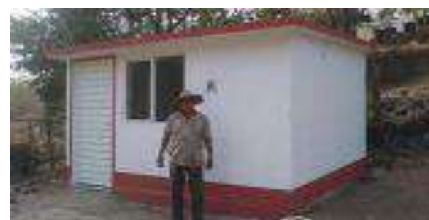
Cuarto Dormitorio Terminado.
