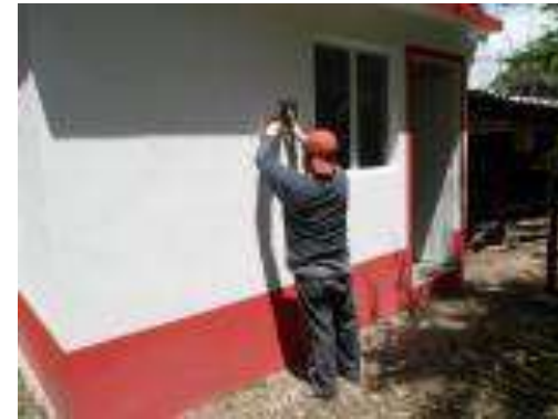
Cuarto Dormitorio Terminado.
