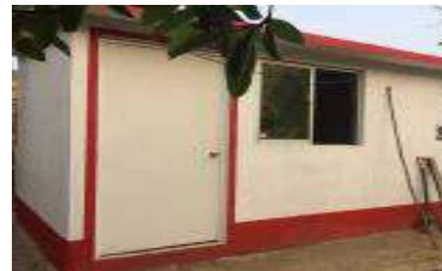
Cuarto Dormitorio Terminado.
