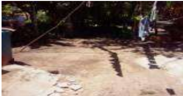
Trazo, excavación y/o desplantes del Cuarto Dormitorio.
