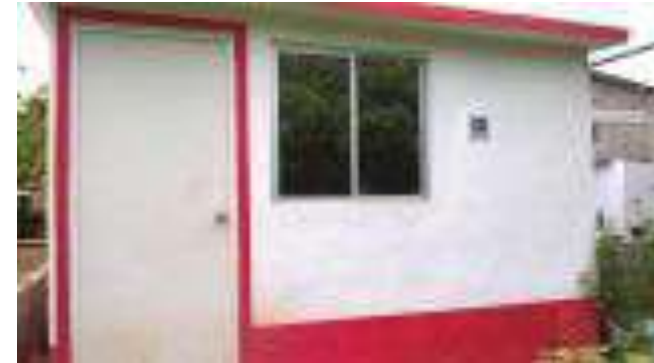
Cuarto Dormitorio Terminado.
