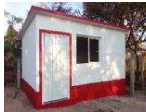
Cuarto Dormitorio Terminado.
