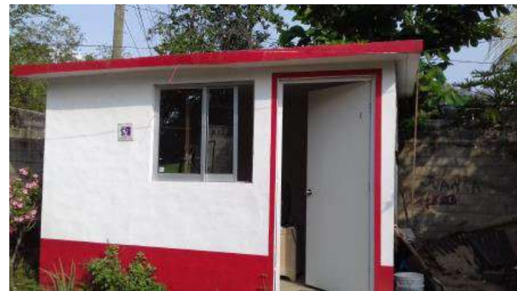
Cuarto Dormitorio Terminado.
