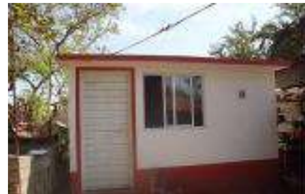
Cuarto Dormitorio Terminado.
