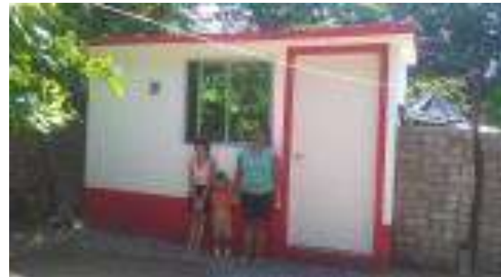
Cuarto Dormitorio Terminado.
