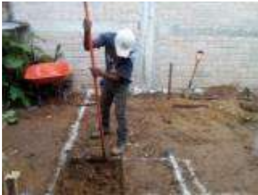
Trazo, excavación y/o desplantes del Cuarto Dormitorio.
