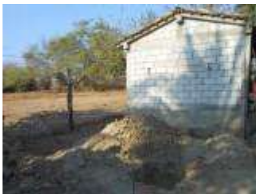
Trazo, excavación y/o desplantes del Cuarto Dormitorio.
