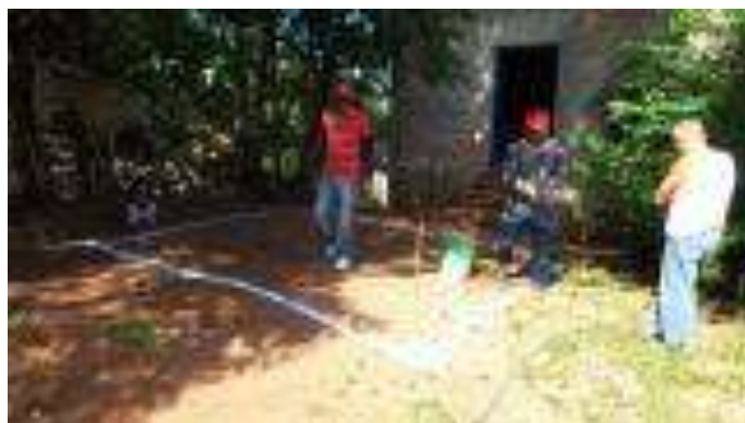
Trazo, excavación y/o desplantes del Cuarto Dormitorio.
