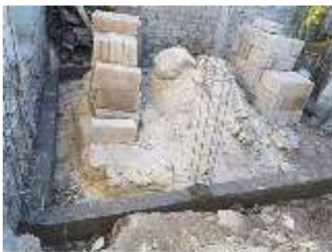
Trazo, excavación y/o desplantes del Cuarto Dormitorio.
