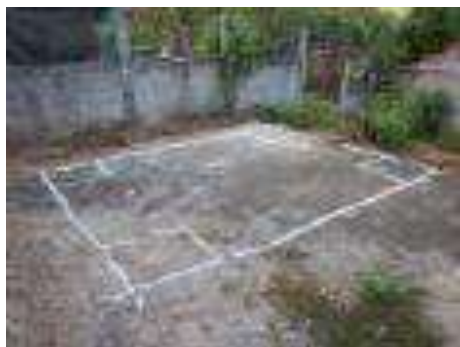
Trazo, excavación y/o desplantes del Cuarto Dormitorio.
