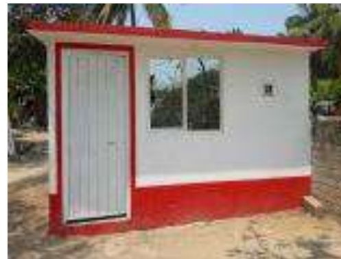
Cuarto Dormitorio Terminado.
