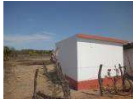
Cuarto Dormitorio Terminado.
