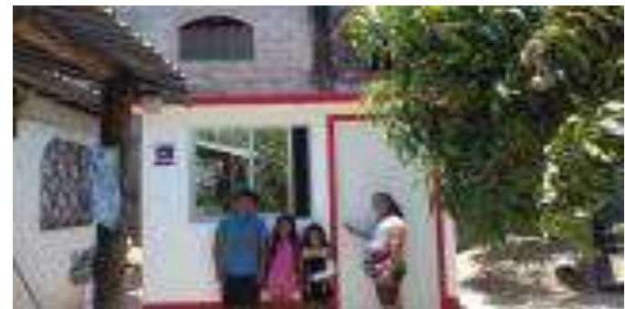
Cuarto Dormitorio Terminado.
