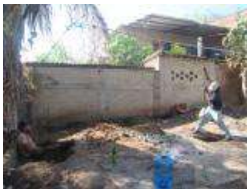
Trazo, excavación y/o desplantes del Cuarto Dormitorio.
