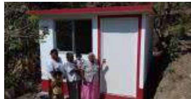
Cuarto Dormitorio Terminado.
