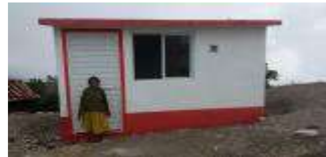
Cuarto Dormitorio Terminado.
