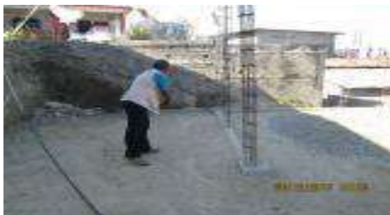
Trazo, excavación y/o desplantes del Cuarto Dormitorio.
