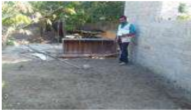
Trazo, excavación y/o desplantes del Cuarto Dormitorio.
