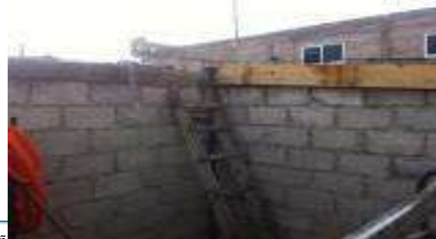
Albañería (Levantamientos de muros y/o colado de loza)
