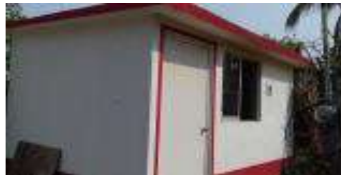
Cuarto Dormitorio Terminado.
