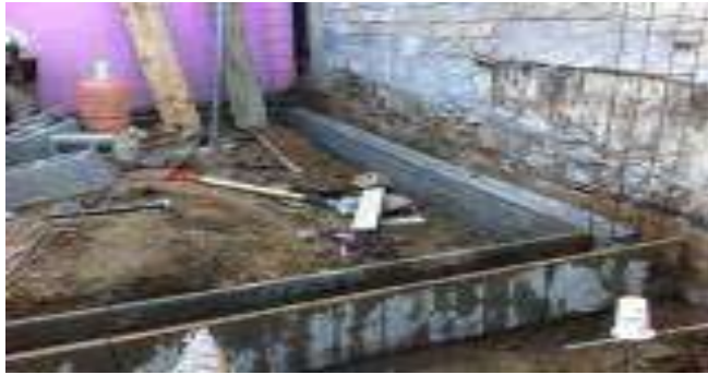
Trazo, excavación y/o desplantes del Cuarto Dormitorio.
