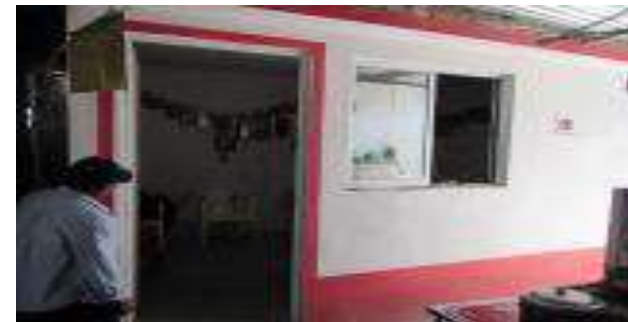
Cuarto Dormitorio Terminado.
