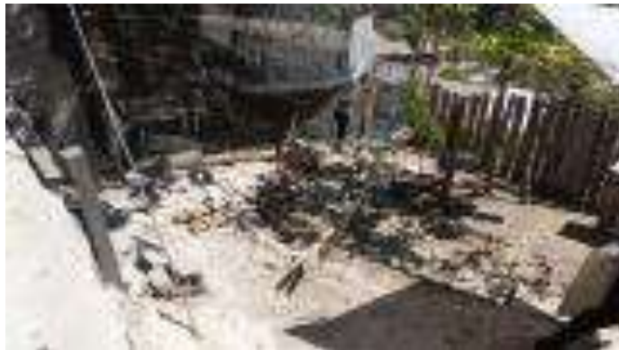
Trazo, excavación y/o desplantes del Cuarto Dormitorio.
