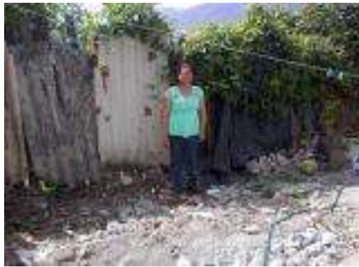
Trazo, excavación y/o desplantes del Cuarto Dormitorio.
