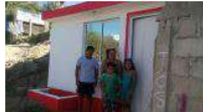
Cuarto Dormitorio Terminado.
