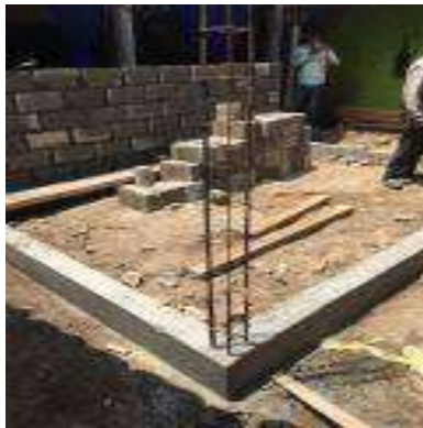
Trazo, excavación y/o desplantes del Cuarto Dormitorio.
