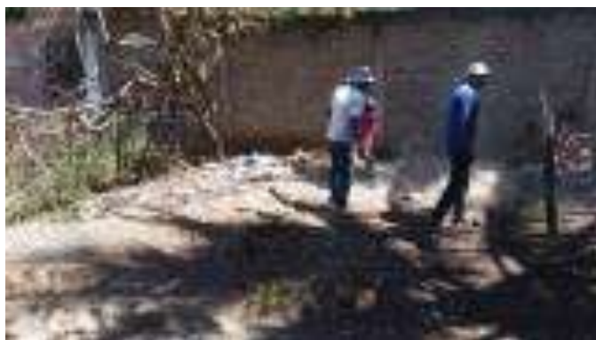
Trazo, excavación y/o desplantes del Cuarto Dormitorio.
