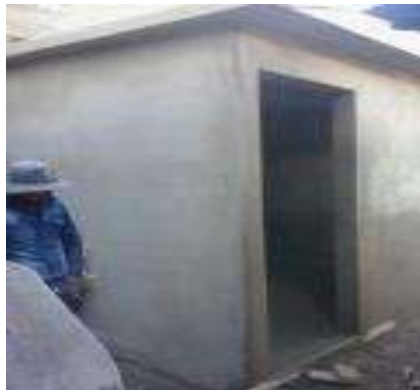
Albañilería (Levantamientos de muros y/o colado de loza)
