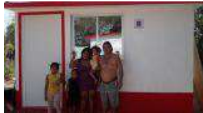
Cuarto Dormitorio Terminado.
