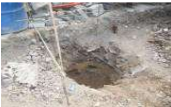
Trazo, excavación y/o desplantes del Cuarto Dormitorio.
