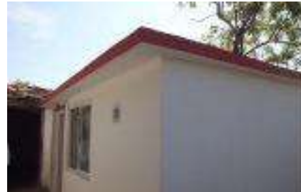
Cuarto Dormitorio Terminado.
