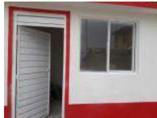
Cuarto Dormitorio Terminado.
