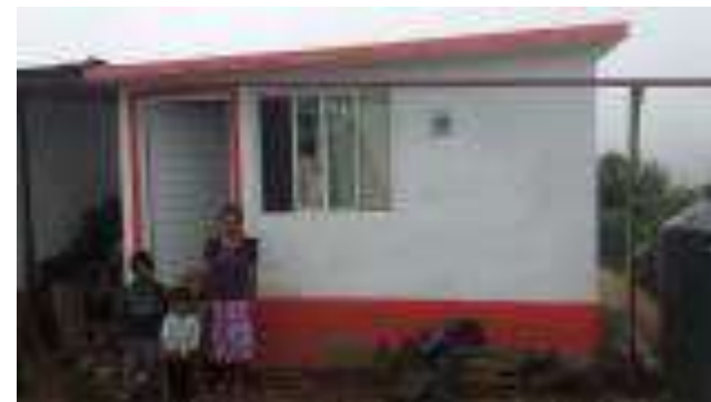
Cuarto Dormitorio Terminado.
