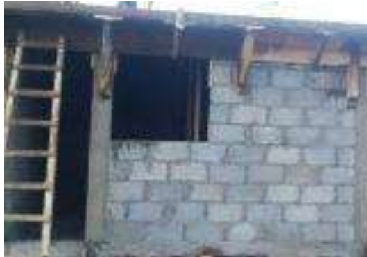
Albañilería (Levantamientos de muros y/o colado de loza)
