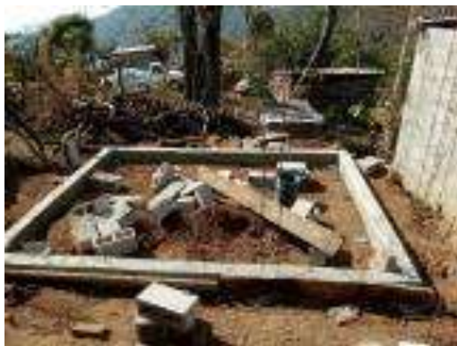
Trazo, excavación y/o desplantes del Cuarto Dormitorio.
