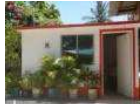
Cuarto Dormitorio Terminado.
