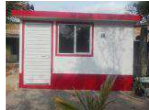
Cuarto Dormitorio Terminado.
