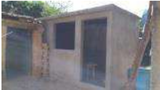
Albañilería (Levantamientos de muros y/o colado de loza)
