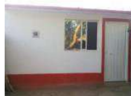
Cuarto Dormitorio Terminado.
