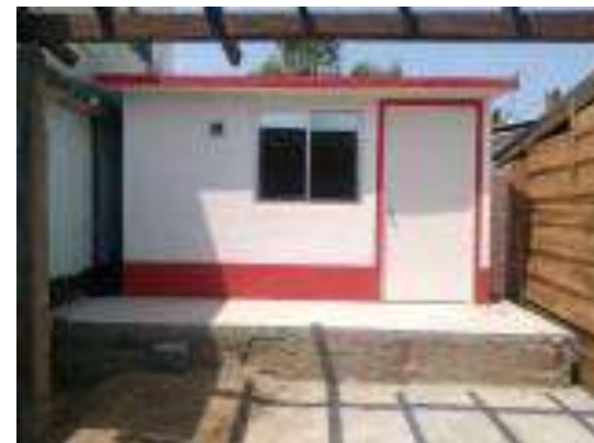
Cuarto Dormitorio Terminado.
