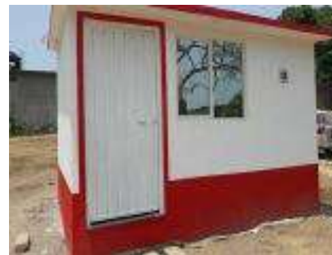
Cuarto Dormitorio Terminado.
