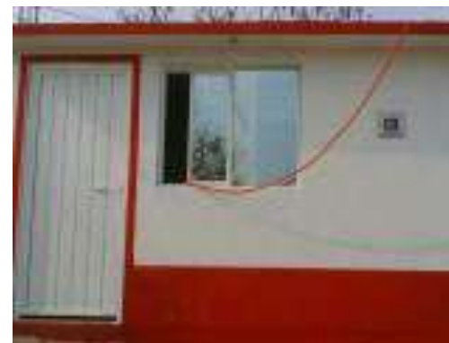
Cuarto Dormitorio Terminado.
