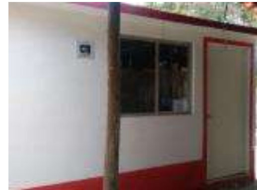
Cuarto Dormitorio Terminado.
