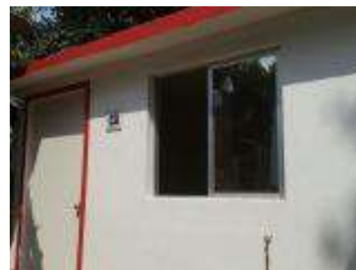
Cuarto Dormitorio Terminado.
