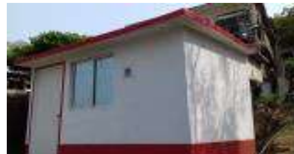
Cuarto Dormitorio Terminado.
