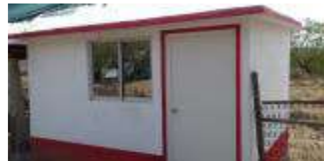
Cuarto Dormitorio Terminado.
