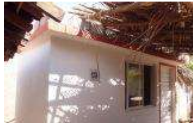
Cuarto Dormitorio Terminado.
