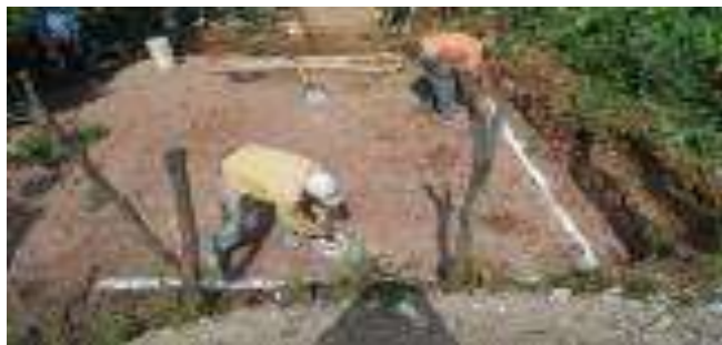
Trazo, excavación y/o desplantes del Cuarto Dormitorio.
