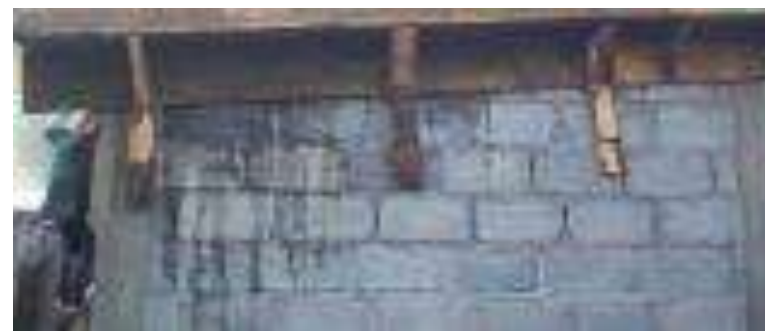
Albañilería (Levantamientos de muros y/o colado de loza)
