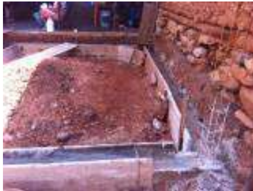
Trazo, excavación y/o desplantes del Cuarto Dormitorio.
