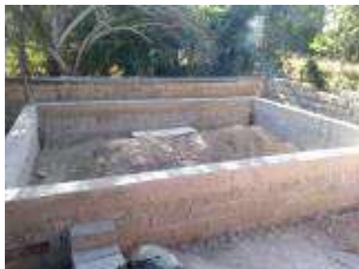
Trazo, excavación y/o desplantes del Cuarto Dormitorio.
