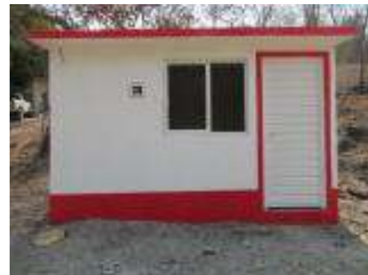
Cuarto Dormitorio Terminado.
