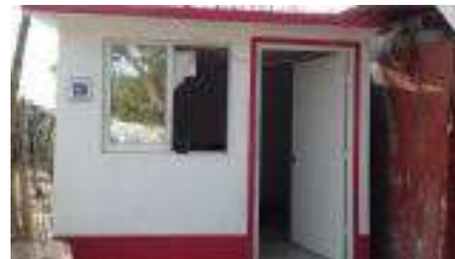
Cuarto Dormitorio Terminado.
