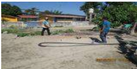
Trazo, excavación y/o desplantes del Cuarto Dormitorio.
