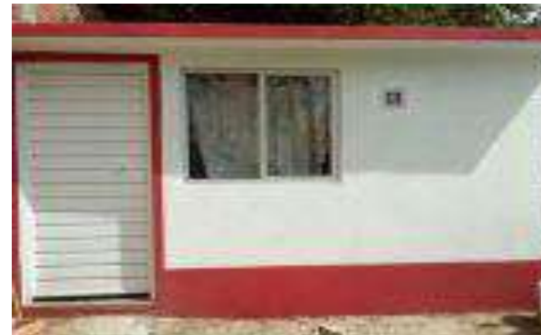
Cuarto Dormitorio Terminado.
