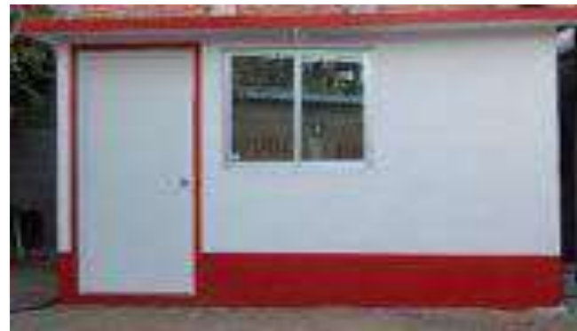
Cuarto Dormitorio Terminado.
