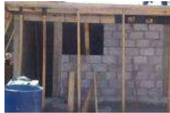
Albañilería (Levantamientos de muros y/o colado de loza)
