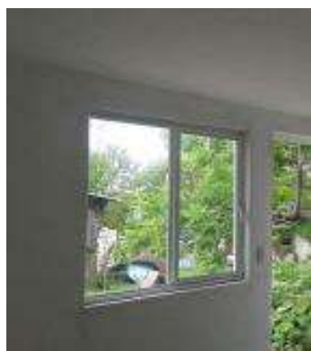
Albañilería (Levantamientos de muros y/o colado de loza)
