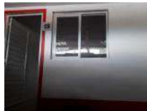
Cuarto Dormitorio Terminado.
