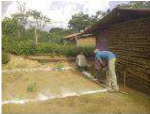
Trazo, excavación y/o desplantes del Cuarto Dormitorio.
