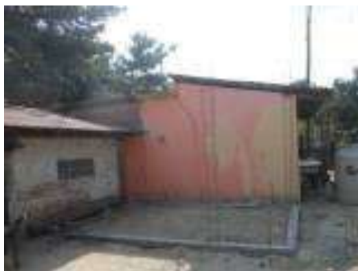
Trazo, excavación y/o desplantes del Cuarto Dormitorio.
