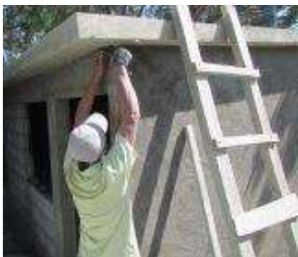
Albañilería (Levantamientos de muros y/o colado de loza)
