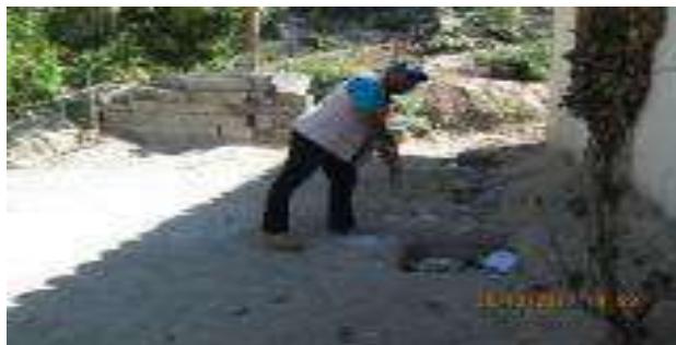
Trazo, excavación y/o desplantes del Cuarto Dormitorio.
