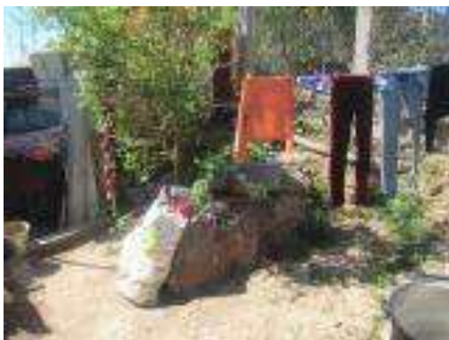
Trazo, excavación y/o desplantes del Cuarto Dormitorio.
