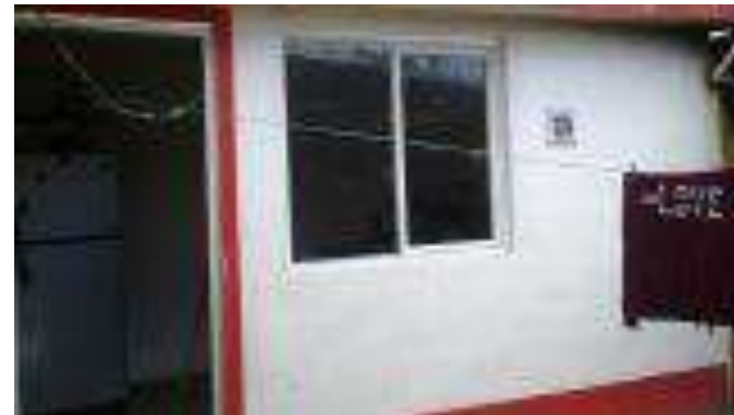
Cuarto Dormitorio Terminado.
