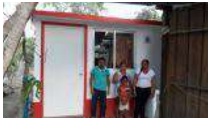
Cuarto Dormitorio Terminado.
