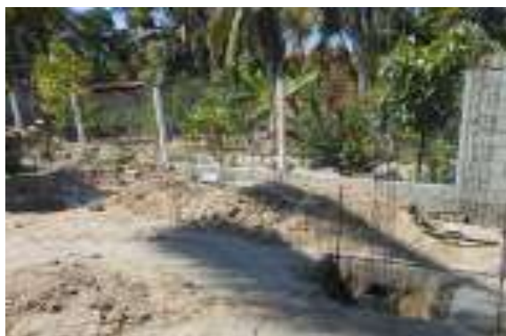
Trazo, excavación y/o desplantes del Cuarto Dormitorio.
