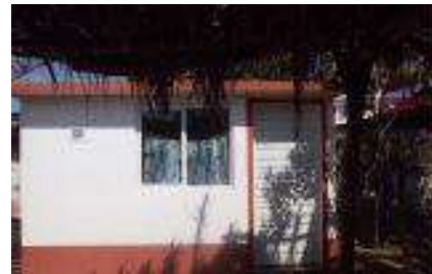
Cuarto Dormitorio Terminado.
