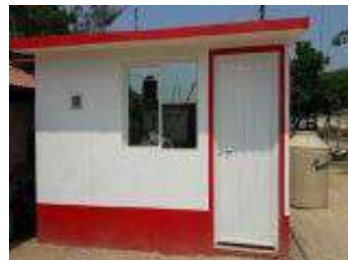
Cuarto Dormitorio Terminado.
