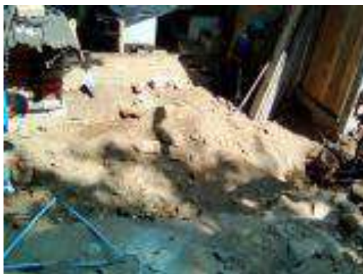
Trazo, excavación y/o desplantes del Cuarto Dormitorio.
