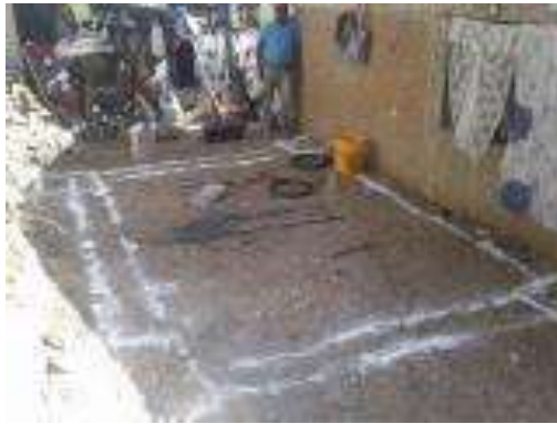
Trazo, excavación y/o desplantes del Cuarto Dormitorio.
