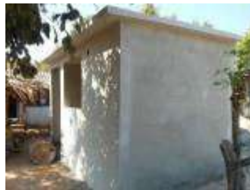
Albañilería (Levantamientos de muros y/o colado de loza)
