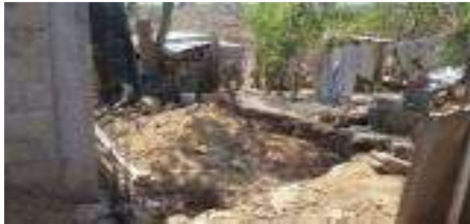
Trazo, excavación y/o desplantes del Cuarto Dormitorio.
