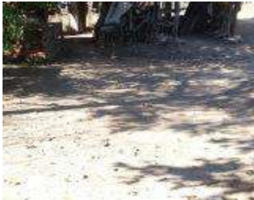
Trazo, excavación y/o desplantes del Cuarto Dormitorio.
