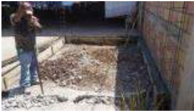
Trazo, excavación y/o desplantes del Cuarto Dormitorio.
