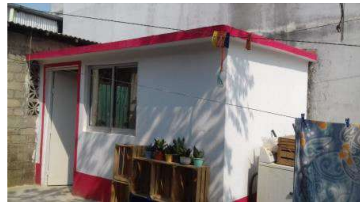
Cuarto Dormitorio Terminado.
