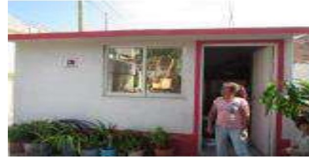
Cuarto Dormitorio Terminado.
