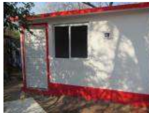
Cuarto Dormitorio Terminado.
