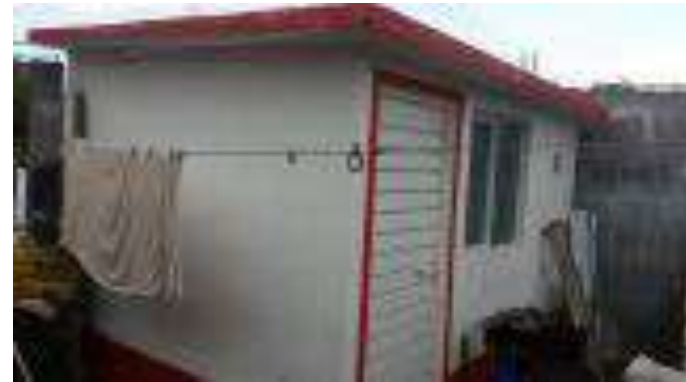
Cuarto Dormitorio Terminado.
