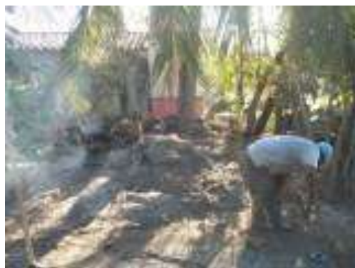
Trazo, excavación y/o desplantes del Cuarto Dormitorio.
