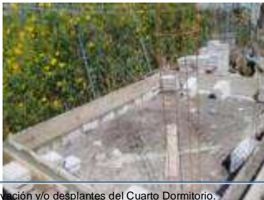
Trazo, excavación y/o desplantes del Cuarto Dormitorio.
