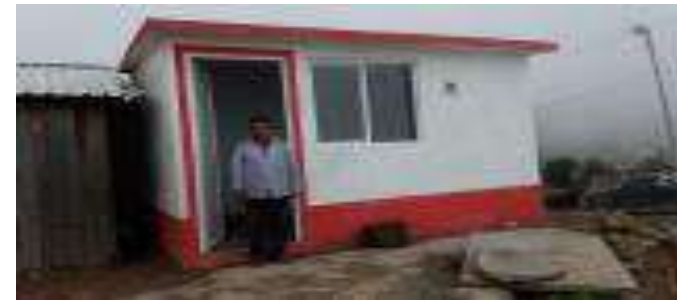
Cuarto Dormitorio Terminado.
