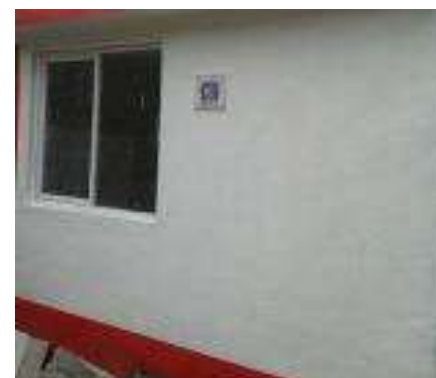
Cuarto Dormitorio Terminado.
