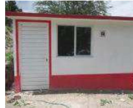
Cuarto Dormitorio Terminado.
