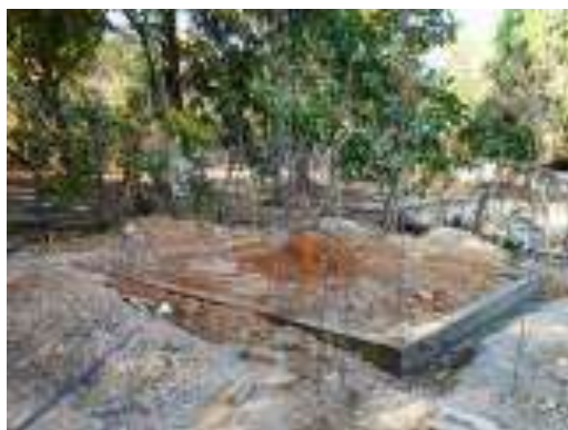
Trazo, excavación y/o desplantes del Cuarto Dormitorio.
