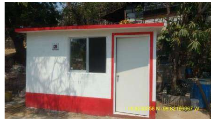
Cuarto Dormitorio Terminado.
