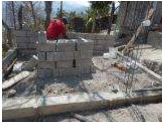
Trazo, excavación y/o desplantes del Cuarto Dormitorio.
