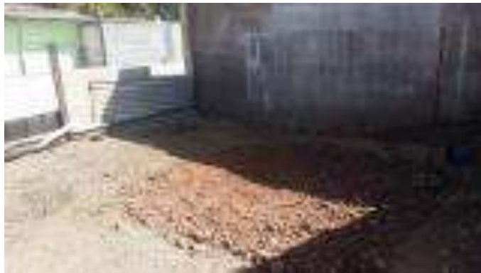
Trazo, excavación y/o desplantes del Cuarto Dormitorio.
