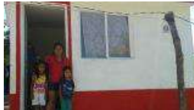
Cuarto Dormitorio Terminado.
