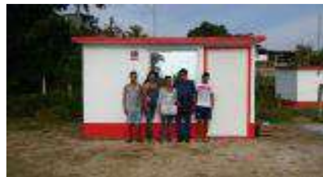
Cuarto Dormitorio Terminado.
