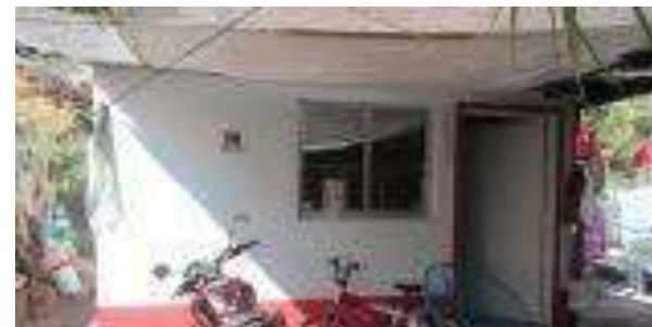
Cuarto Dormitorio Terminado.
