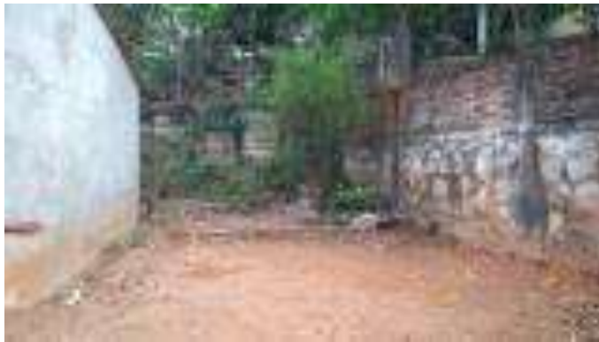
Trazo, excavación y/o desplantes del Cuarto Dormitorio.
