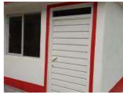
Cuarto Dormitorio Terminado.
