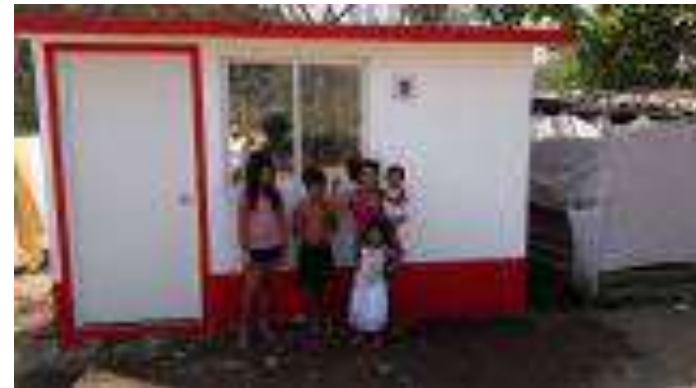
Cuarto Dormitorio Terminado.
