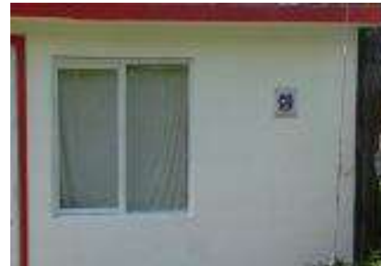
Cuarto Dormitorio Terminado.
