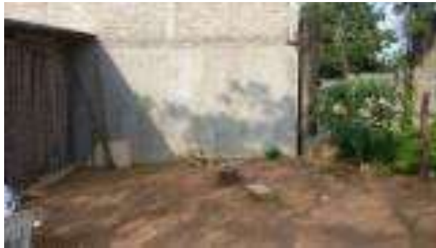
Trazo, excavación y/o desplantes del Cuarto Dormitorio.
