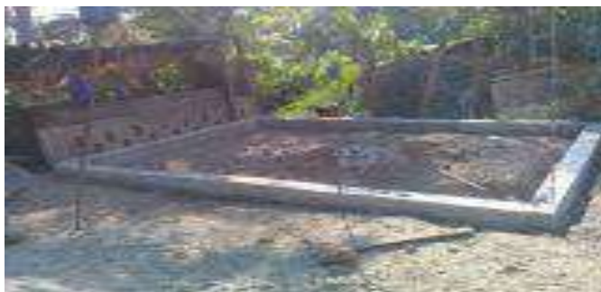
Trazo, excavación y/o desplantes del Cuarto Dormitorio.
