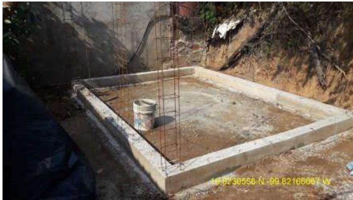
Trazo, excavación y/o desplantes del Cuarto Dormitorio.
