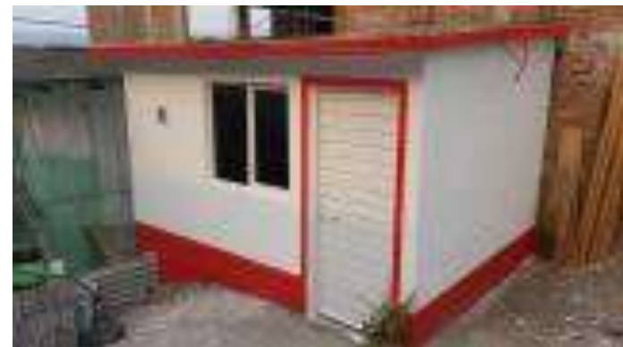
Cuarto Dormitorio Terminado.
