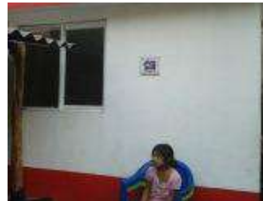
Cuarto Dormitorio Terminado.
