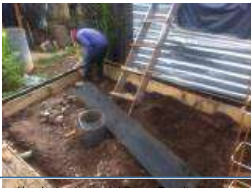
Trazo, excavación y/o desplantes del Cuarto Dormitorio.
