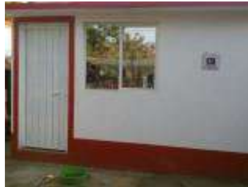
Cuarto Dormitorio Terminado.
