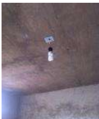
Albañilería (Levantamientos de muros y/o colado de loza)
