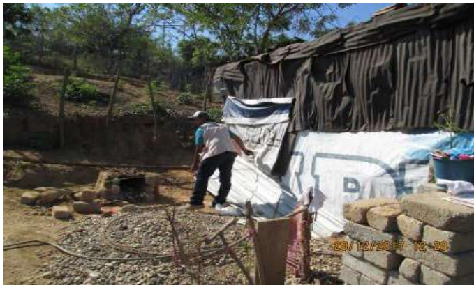
Trazo, excavación y/o desplantes del Cuarto Dormitorio.
