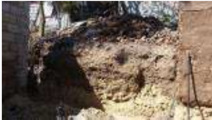
Trazo, excavación y/o desplantes del Cuarto Dormitorio.
