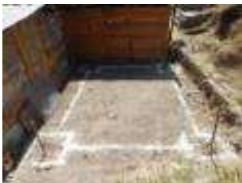
Trazo, excavación y/o desplantes del Cuarto Dormitorio.
