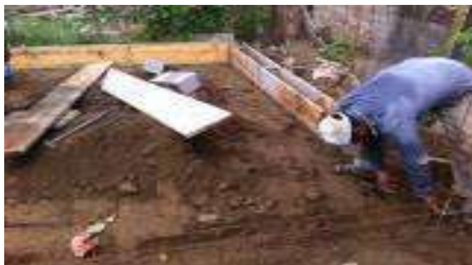
Trazo, excavación y/o desplantes del Cuarto Dormitorio.
