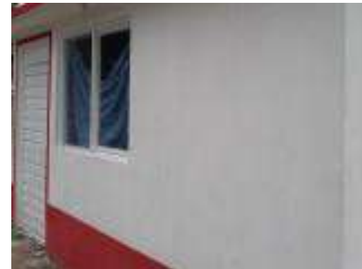
Cuarto Dormitorio Terminado.
