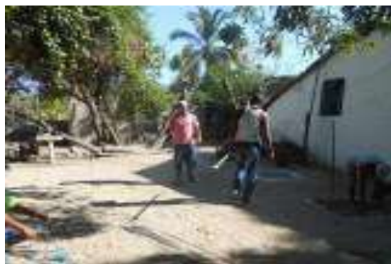
Trazo, excavación y/o desplantes del Cuarto Dormitorio.
