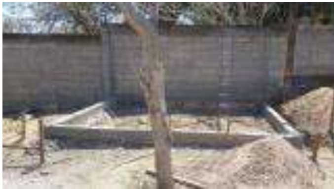
Trazo, excavación y/o desplantes del Cuarto Dormitorio.
