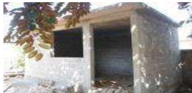
Albañilería (Levantamientos de muros y/o colado de loza)
