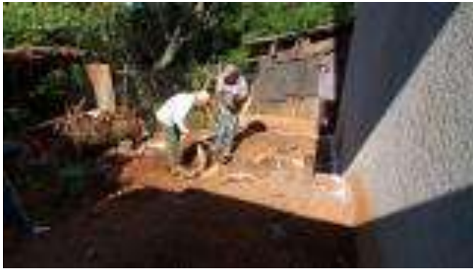
Trazo, excavación y/o desplantes del Cuarto Dormitorio.
