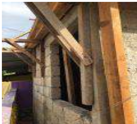
Albañilería (Levantamientos de muros y/o colado de loza)
