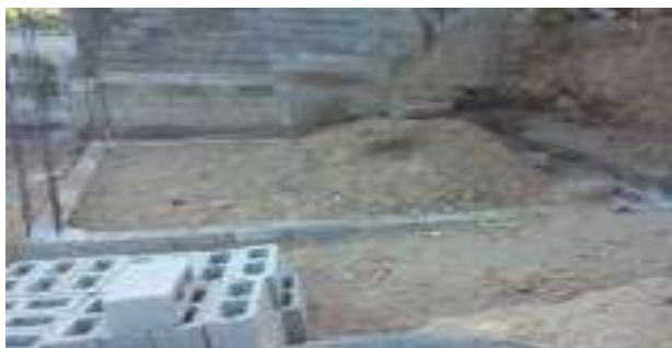
Trazo, excavación y/o desplantes del Cuarto Dormitorio.
