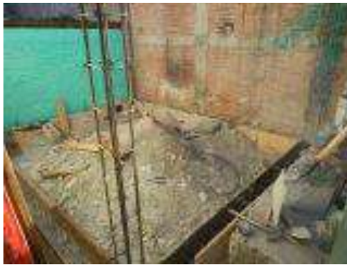
Trazo, excavación y/o desplantes del Cuarto Dormitorio.
