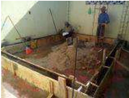
Trazo, excavación y/o desplantes del Cuarto Dormitorio.
