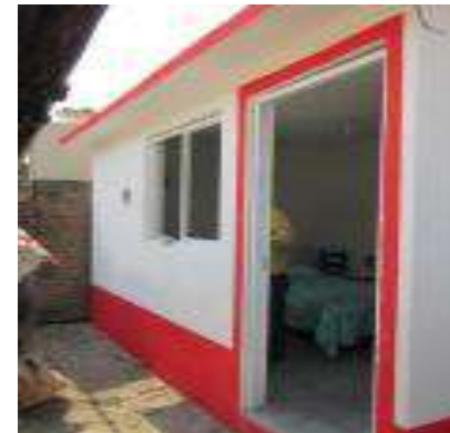
Cuarto Dormitorio Terminado.
