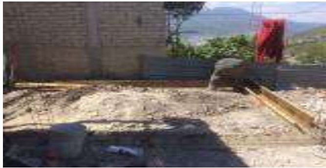
Trazo, excavación y/o desplantes del Cuarto Dormitorio.
