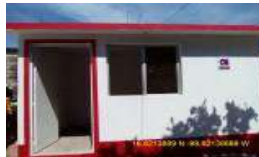
Cuarto Dormitorio Terminado.
