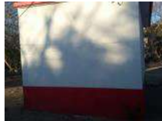
Cuarto Dormitorio Terminado.
