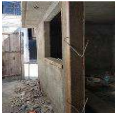
Albañilería (Levantamientos de muros y/o colado de loza)
