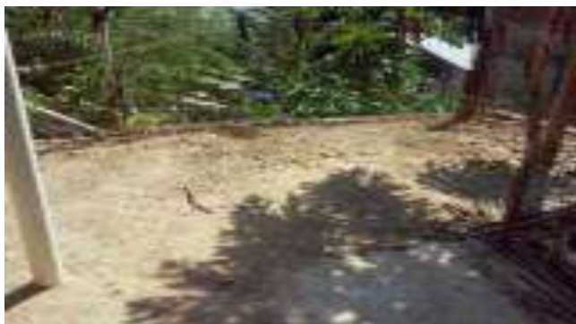
Trazo, excavación y/o desplantes del Cuarto Dormitorio.
