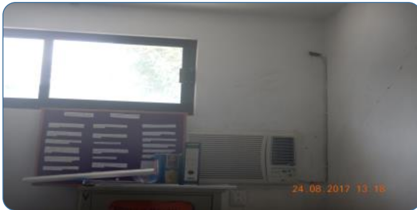
Sustitución de unidades de aire acondicionado
