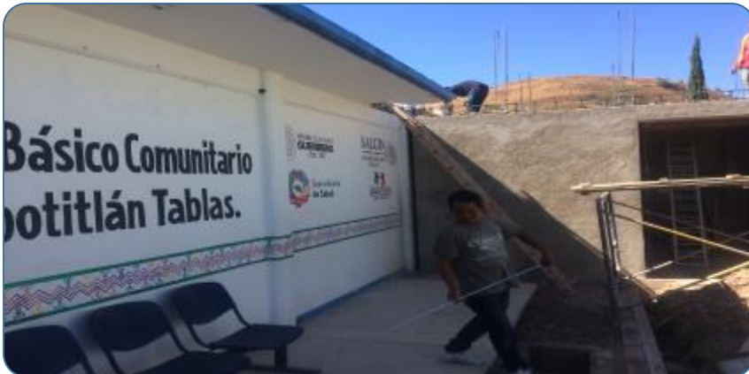
Aplanados en muros de acceso a consultorio de urgencias
