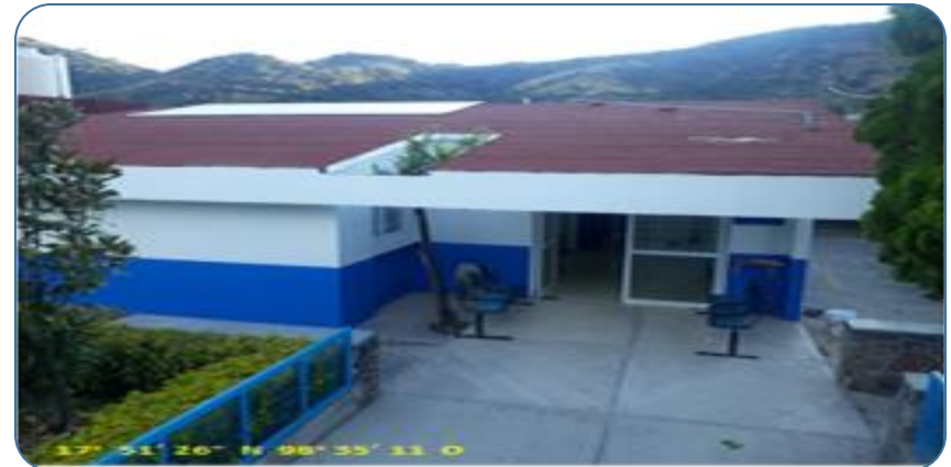
Impermeabilización de azotea, pintura general y puerta principal.
