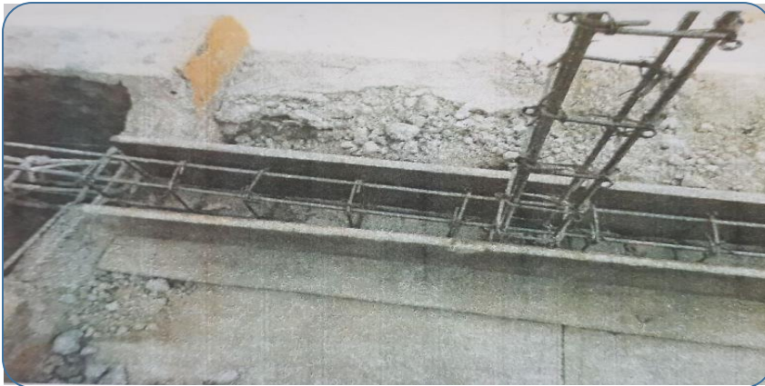
Construcción de cadenas de desplante de muros en urgencias
