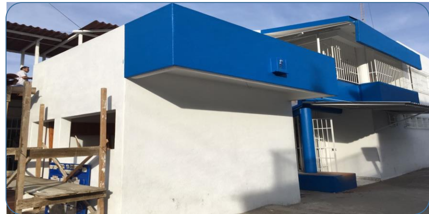
Aplicación de pintura general en muros y plafones
