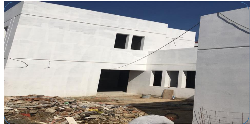
Aplicación de plaste y sellador en muros para pintura general
