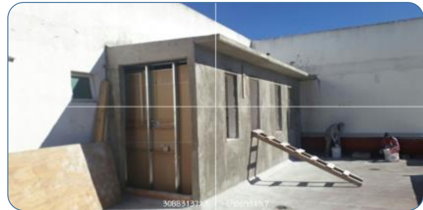
Área de manifold
