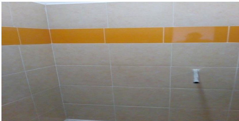
Sustitución de azulejo en sanitarios
