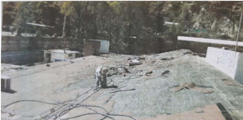
Preparación de superficie para impermeabilización de azotea
