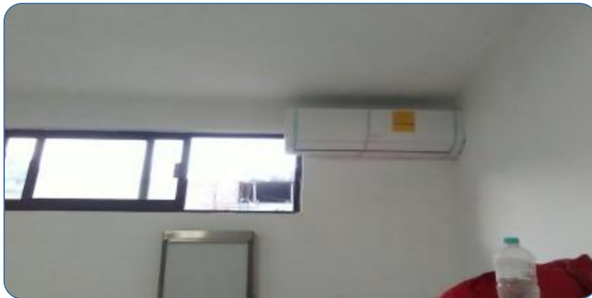
Suministro y colocación de unidades de aire
