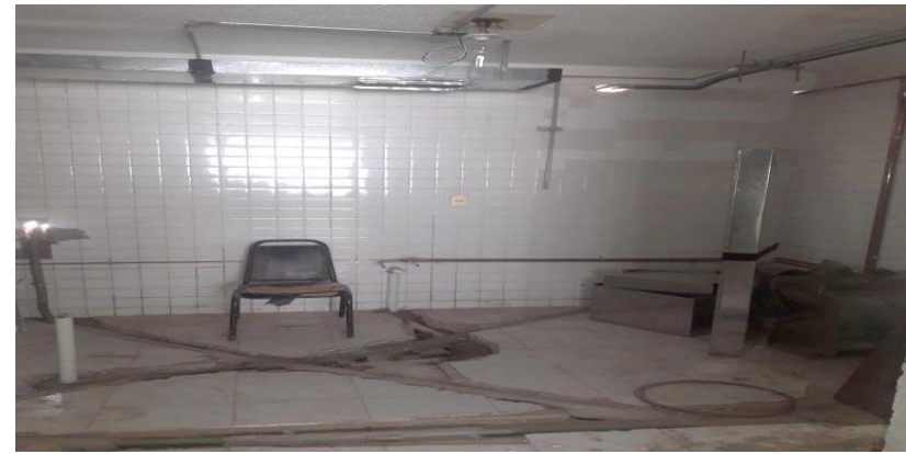
Rehabilitación de red sanitaria e hidráulica, así como sustitución de piso
