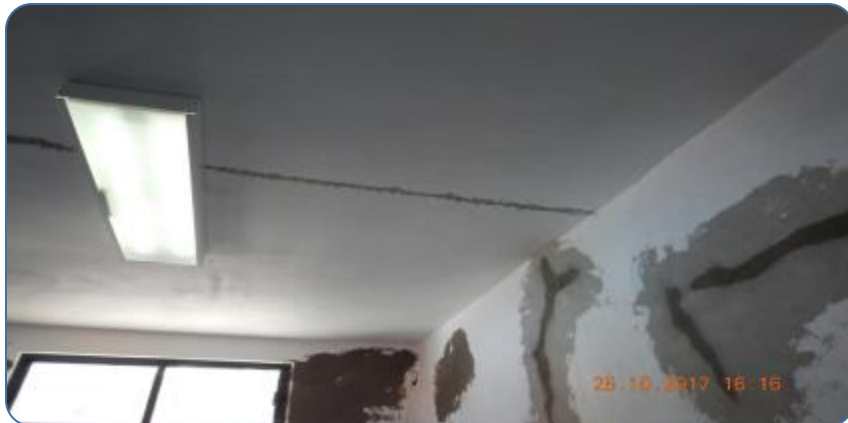
Reparación de fisuras y preparación de superficie para pintura general
