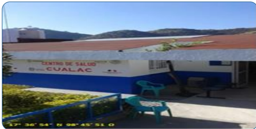
Pintura exterior, e impermeabilización
