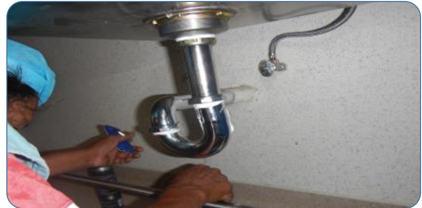
Rehabilitación de muebles sanitarios
