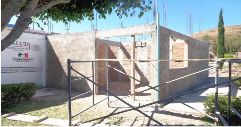
Construcción de área de espera
