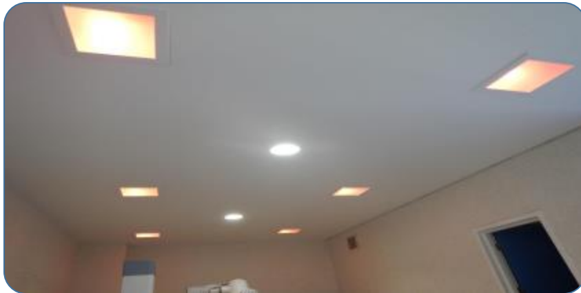
Sustitución de lámparas en plafones y pintura
