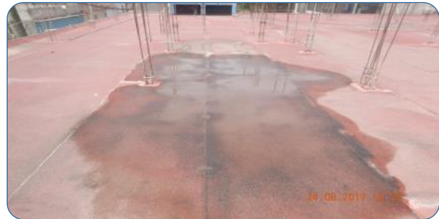
Preparación de superficie para impermeabilizar techumbre
