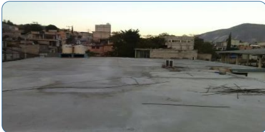
Preparación de superficie para impermeabilizar loza de concreto
