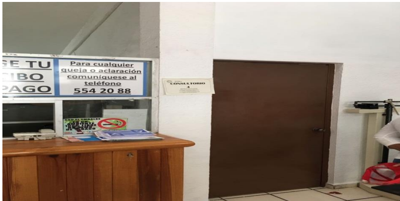
Pintura general en interiores y rehabilitación de puertas de madera
