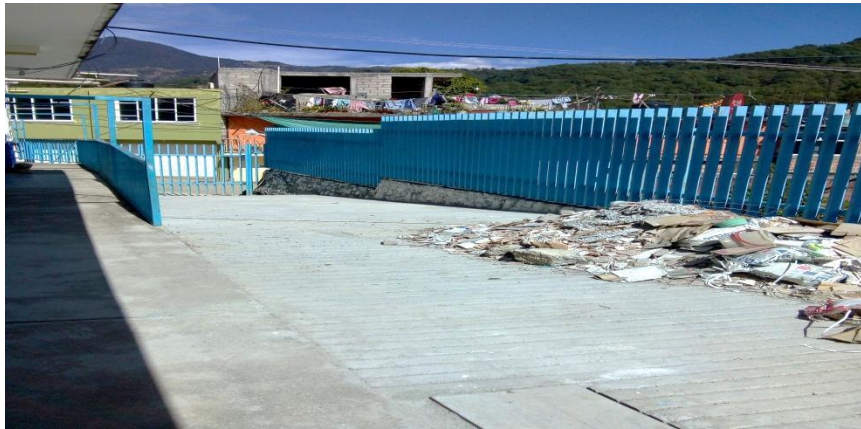
Sustitución de rampa vehicular
