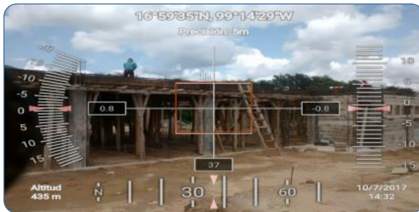
Cimbrado para colado de concreto en lozas y trabes
