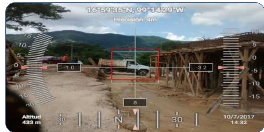
Preparación para colar lozas de concreto
