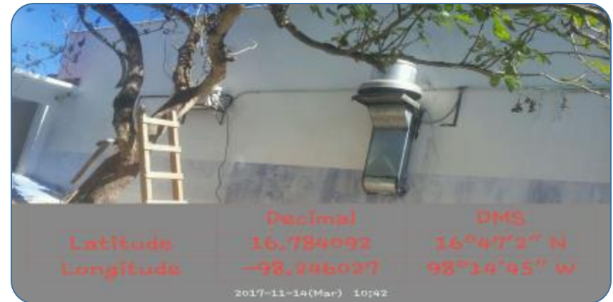
Aplicación de pintura general en exteriores
