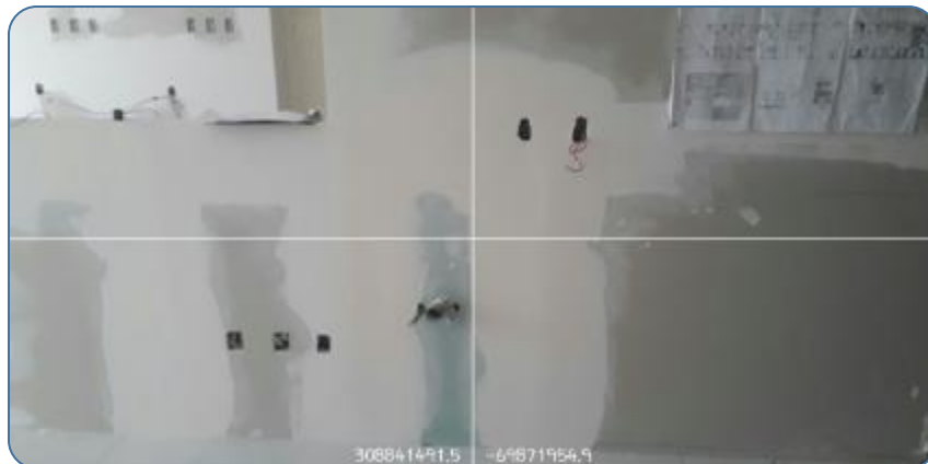
Salidas para gases medicinales y aplicación de sellador para pintura general en muros
