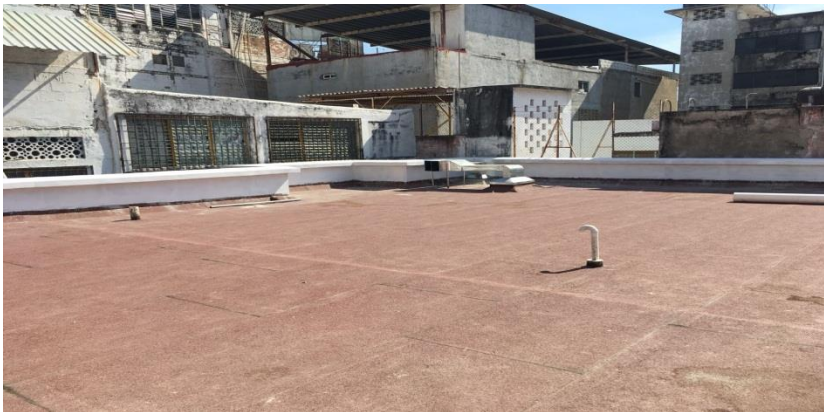
Suministro y colocación de Impermeabilización en azotea
