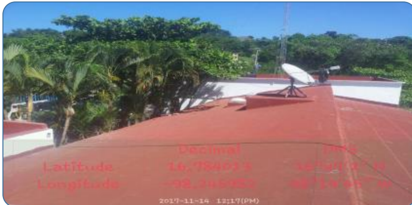
Sustitución de impermeabilización en lozas
