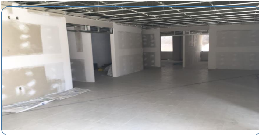
Construcción de muros de tabla roca, falso plafón y piso de loseta de cerámica
