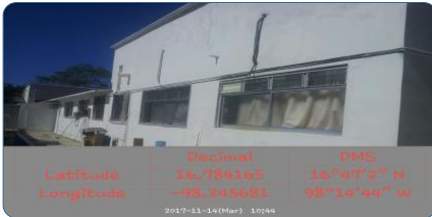
Aplicación de pintura general en exteriores
