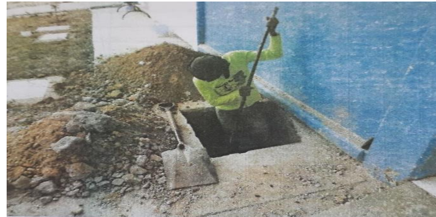
Excavaciones para cimentación de muros en urgencias
