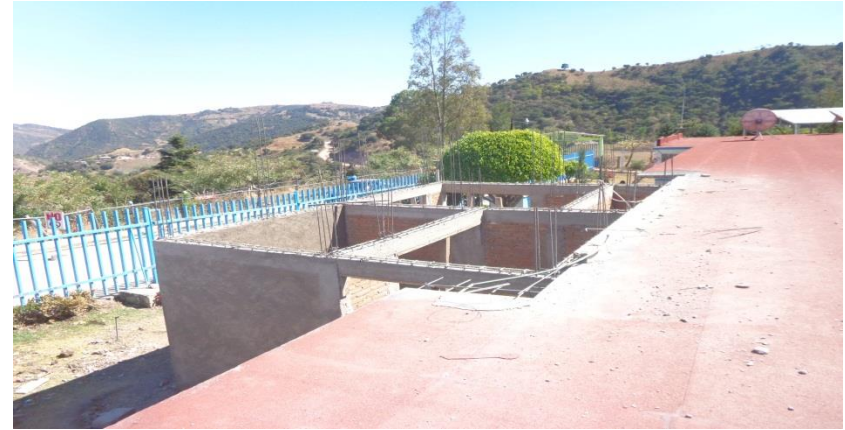
Remodelación del área de urgencias
