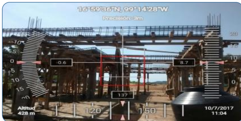
Armado de estructura en trabes y cimbrado
