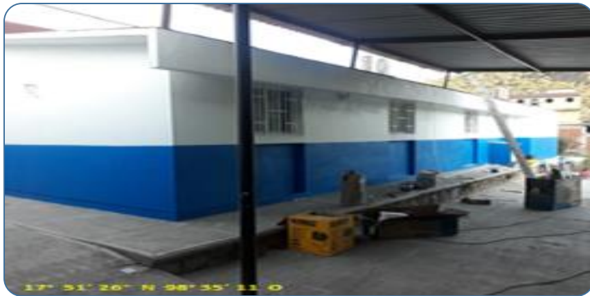
Protecciones en ventanas y pintura general.
