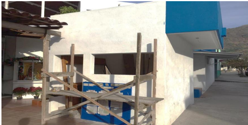
Aplicación de sellador en muros
