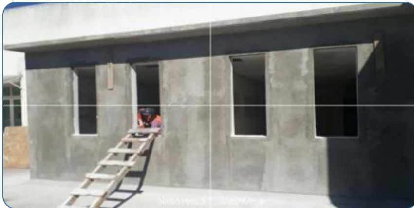
Aplanados y sellador en muros
