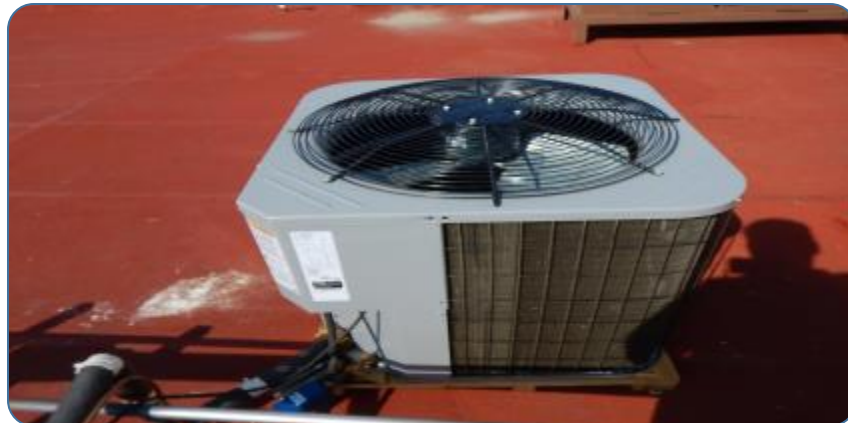
Suministro y colocación de compresores y unidades de aire acondicionado
