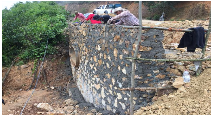
PERSONAL REALIZANDO TRABAJOS DE CONSTRUCCION DEL MURO CABEZOTE AGUAS ABAJO KM. 1+400
