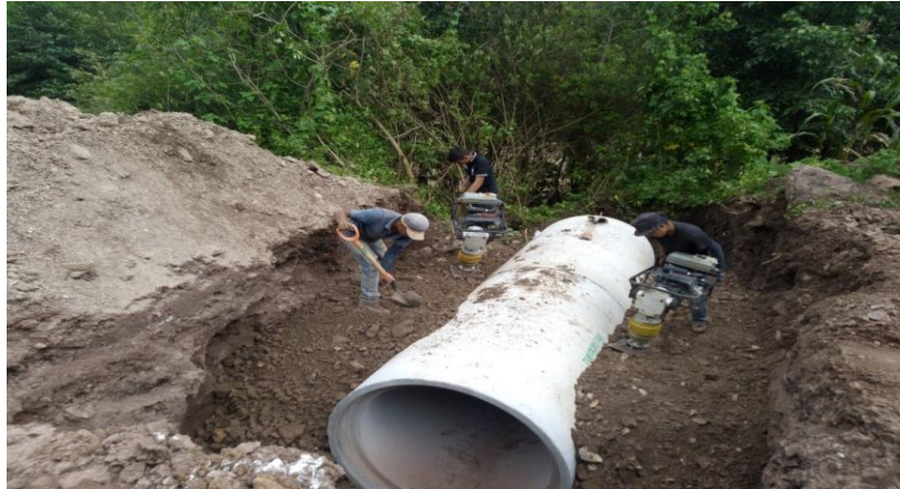
COLOCACION DEL TUBO DE CONCRETO DE 1.20 CMS DE DIAMETRO KM. 1+560
