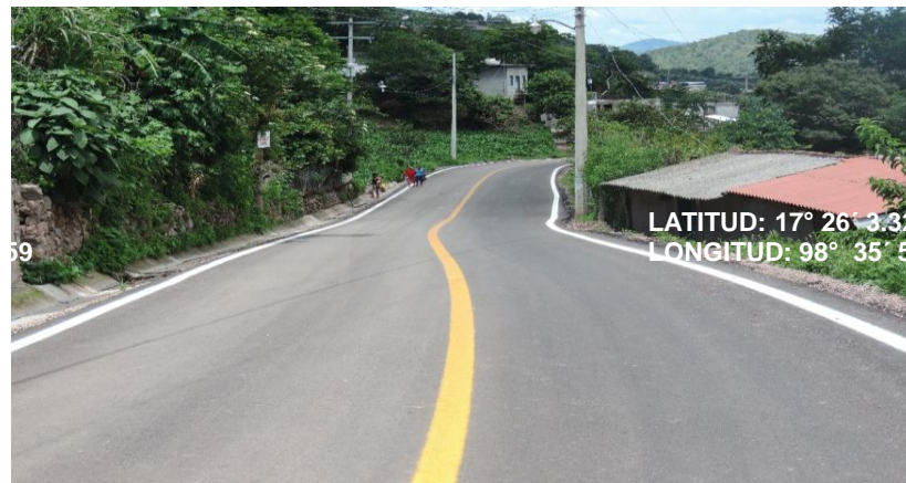
CAMINO REHABILITADO KM. 4+000
