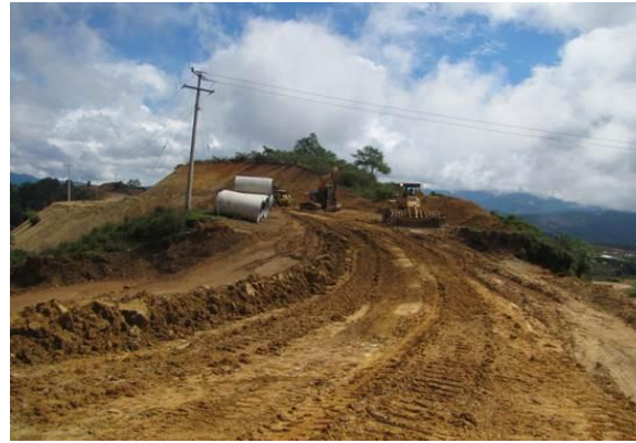
KM. 10+800 CONSTRUCCIÓN SUBRASNTE Y SUMINISTRO DE TUBOS
