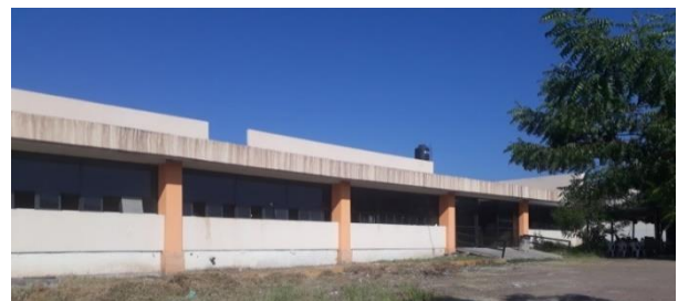
Foto 2.- Edificio de laboratorios y talleres
