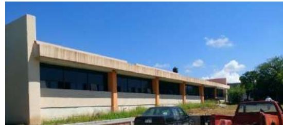
Foto 7.- Edificio de laboratorios y talleres.
