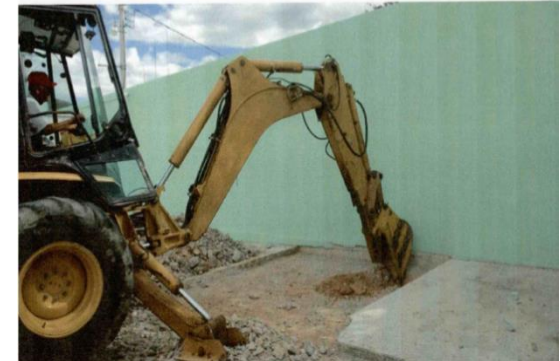
INICIO DE TRABAJOS DE CIMENTACIÓN PARA LA COLOCACIÓN DE LA TORRE Y ENLACE DE TELECOMUNICACIÓN.
